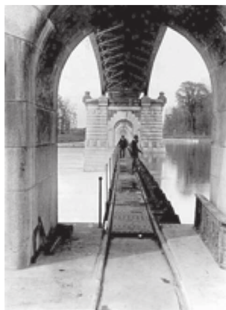
Obr. 7: Jez v Roudnici nad Labem.
