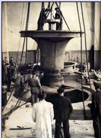
Betonáž turbínových šachet (rok 1943) a montáž turbíny č.2.
