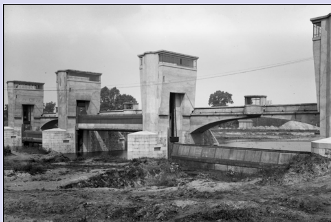
11. června 1929. Pohled z návodní strany, v prvním poli jezu je vidět stavidlo s úhlovou klapkou. Jezový průkop ještě není dokončen.
