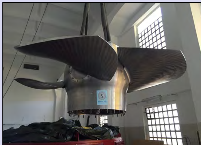
Montáž oběžného kola nové turbíny č.2 dne 25. srpna 2016.
