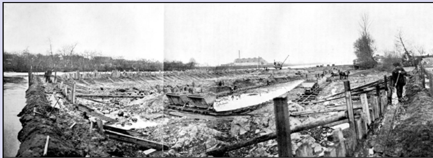
20. listopadu 1912. Odstraňování skály v řece pod neratovickým železničním mostem. Pohled po proudu, vzadu továrna Gustava Šebory (dnes nejstarší část Spolany).
