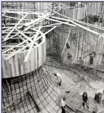
Betonáž turbínových šachet (rok 1943) a montáž turbíny č.2.
