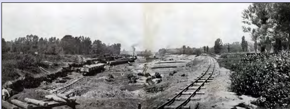
Regulační práce 10. září 1908 severně od Libiše. Pohled po proudu do průkopu „Na jelitě“, dnes naproti severní části Spolany.
