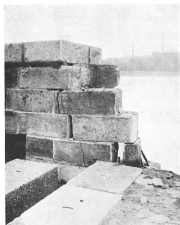
Obr. 10. Přehraň kvádry šachty pro protiváhu.
