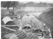
Obr. 3. Kanály centrály na Těšnově ve stavbě.
