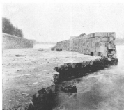
Obr. 9. Stržení zeď a dlažba ve vorové propusti.
