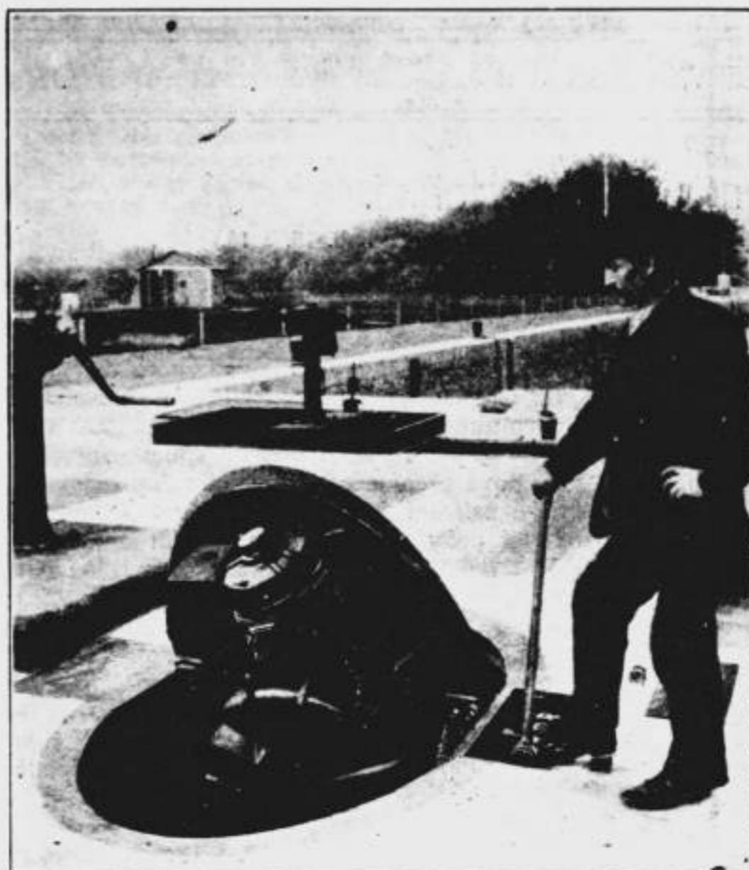
Obr. 9. Naviják ve sklopené poloze. V pozadí mechanismus ku pohybu dolních vrat.
