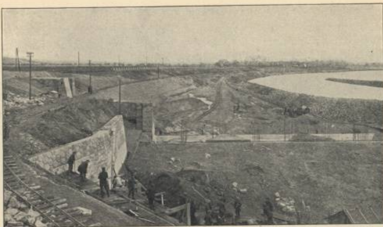
Obr. 52. Stavba vodní elektrárny v Mířevícih. 18. prosince 1923.
