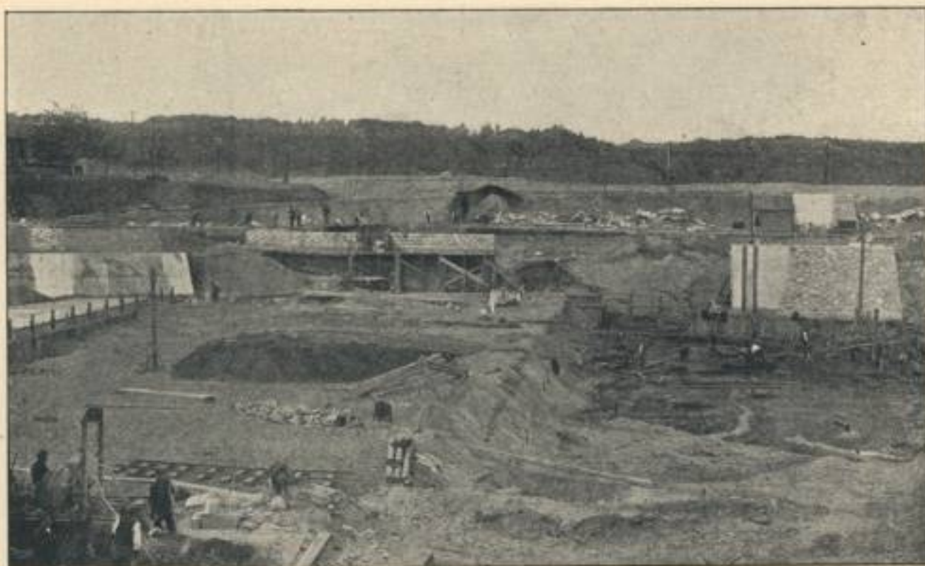
Obr. 51. Stavba vodní elektrárny v Mířetovicích, 23. října 1923.
