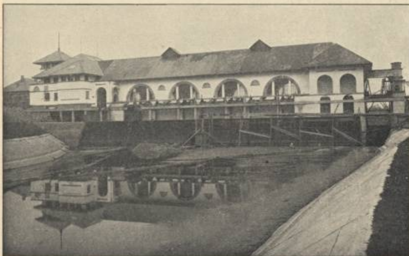
Obr. 60. Vodní elektrárna v Mějevicích. 29. listopadu 1926.
