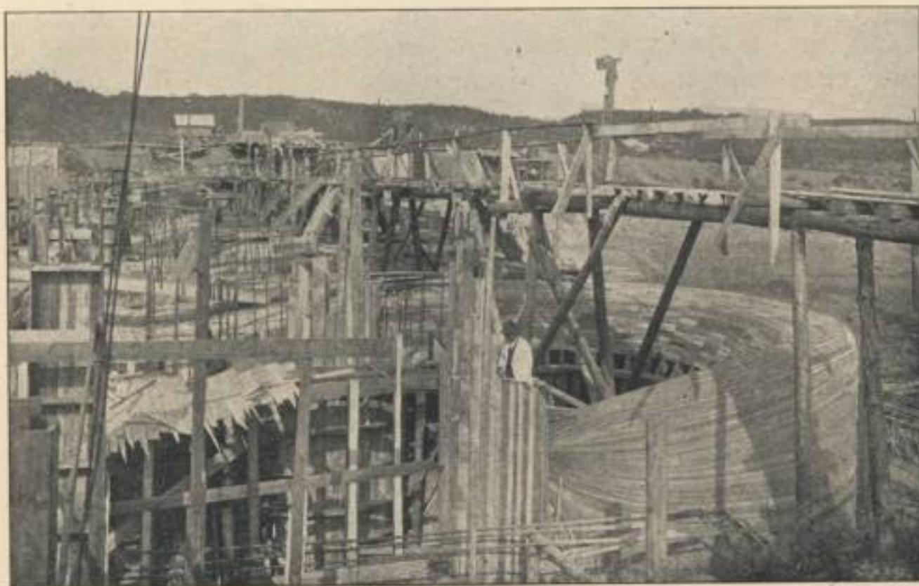
Obr. 55. Stavba vodní elektrárny v Mířejovicích 10. září 1924.
