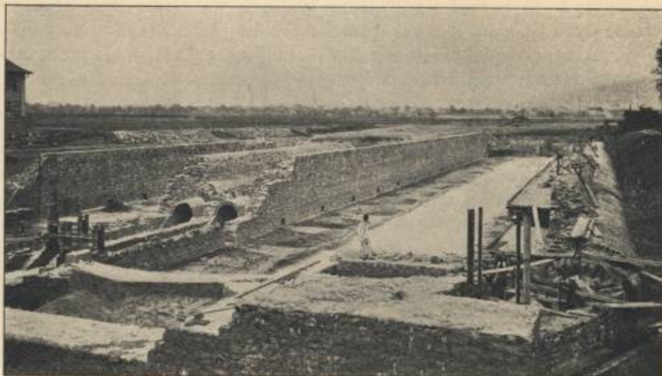
Obr. 3. Postup stavby komorových plavidel v Lovosicích, 2. května 1913.
