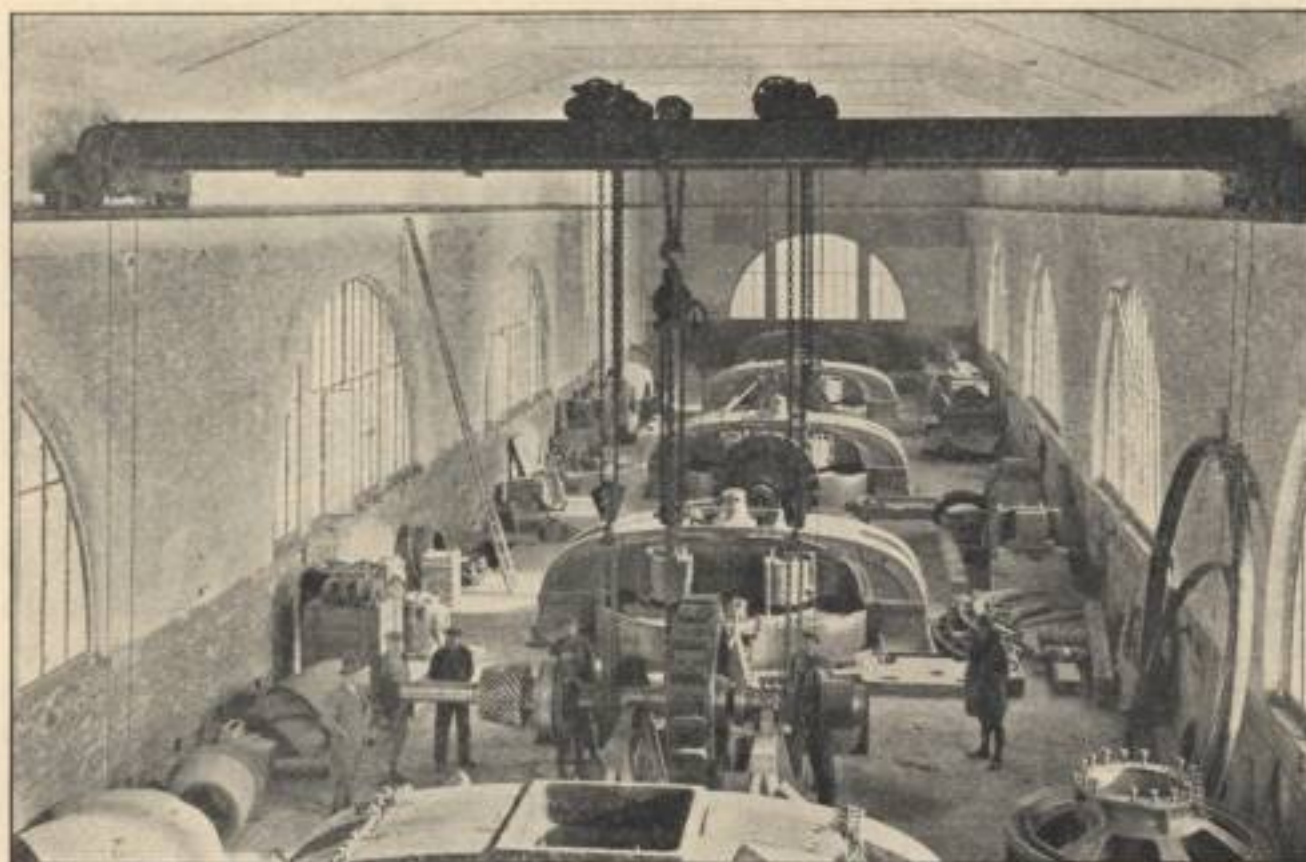
Obr. 62. Montáž turbin a generátorů ve vodní elektrárně v Mířovicích strojárnou Českomoravská-Kolben. 28. ledna 1927.
