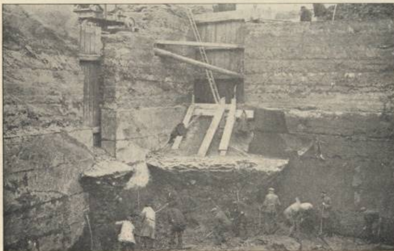
Obr. 21. Masarykovo zdymadlo u Střekova 2. prosince 1926. Zabetonované spáry mezi kesony 4-A a A-5
