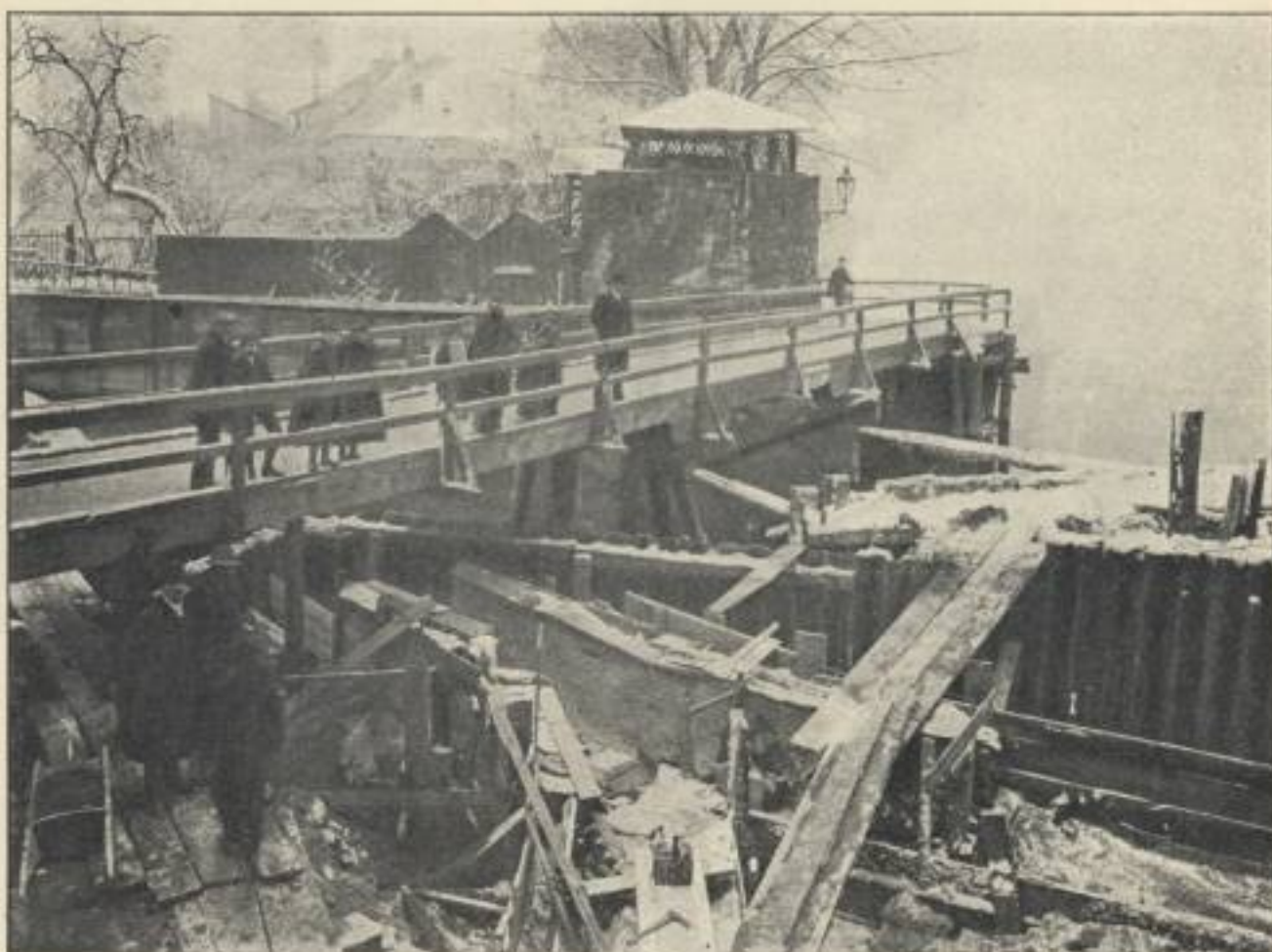
Obr. 32. Stavba městské stoky přes přívodní kanál do Čertovky, 28. prosince 1914.
