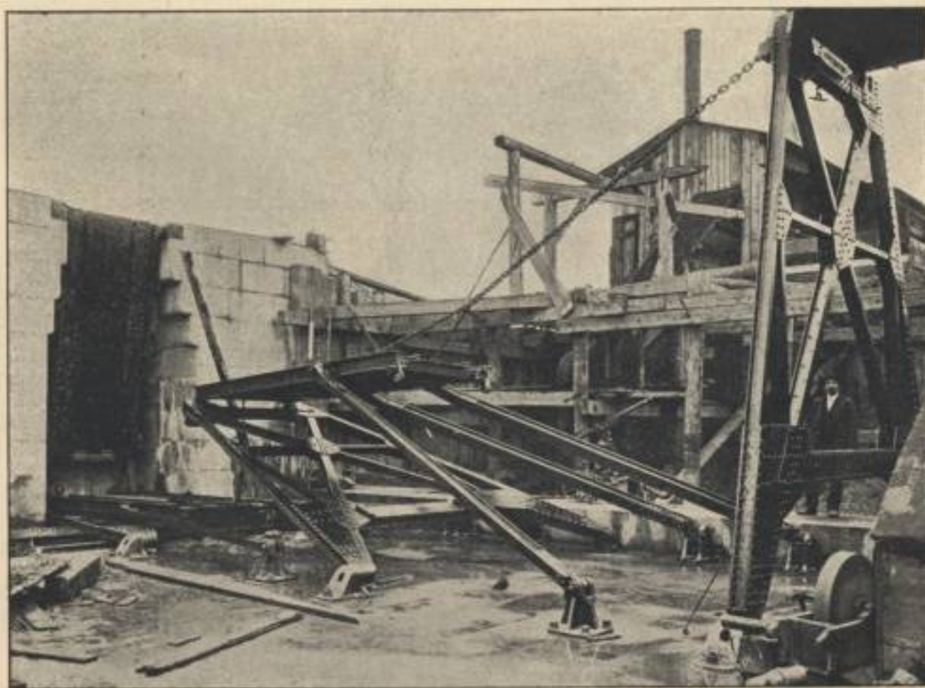
Obr. 2. Schwarzerův jez stavidlový v lodní propusti u Lovosic, 23. října 1913.
