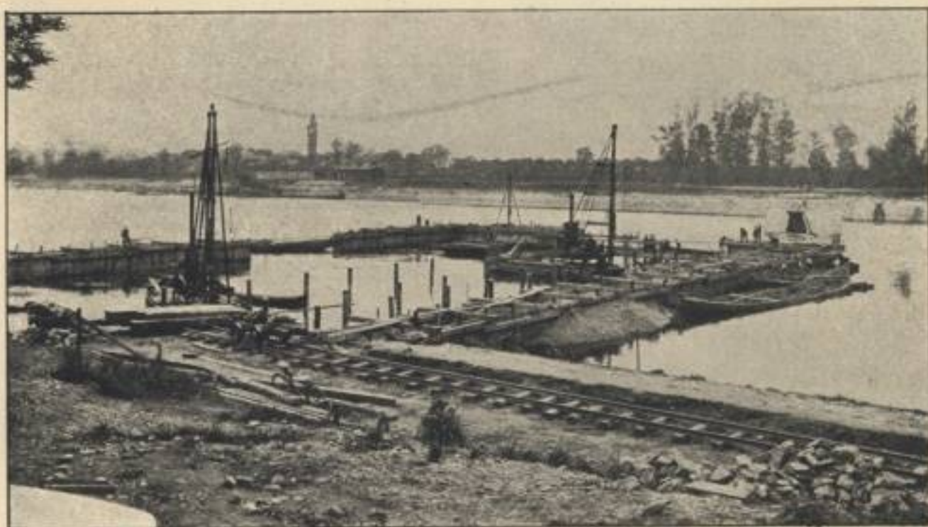
Obr. 6. Jímka pro levý díl jezu v Lovosicích. 5. června 1914.
