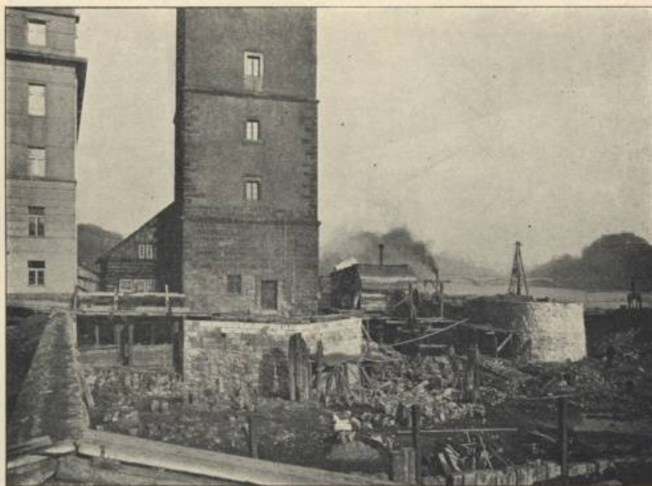
Obr. 28. Postup stavby u smíchovské věže vodárenské. 15. listopadu 1913.
