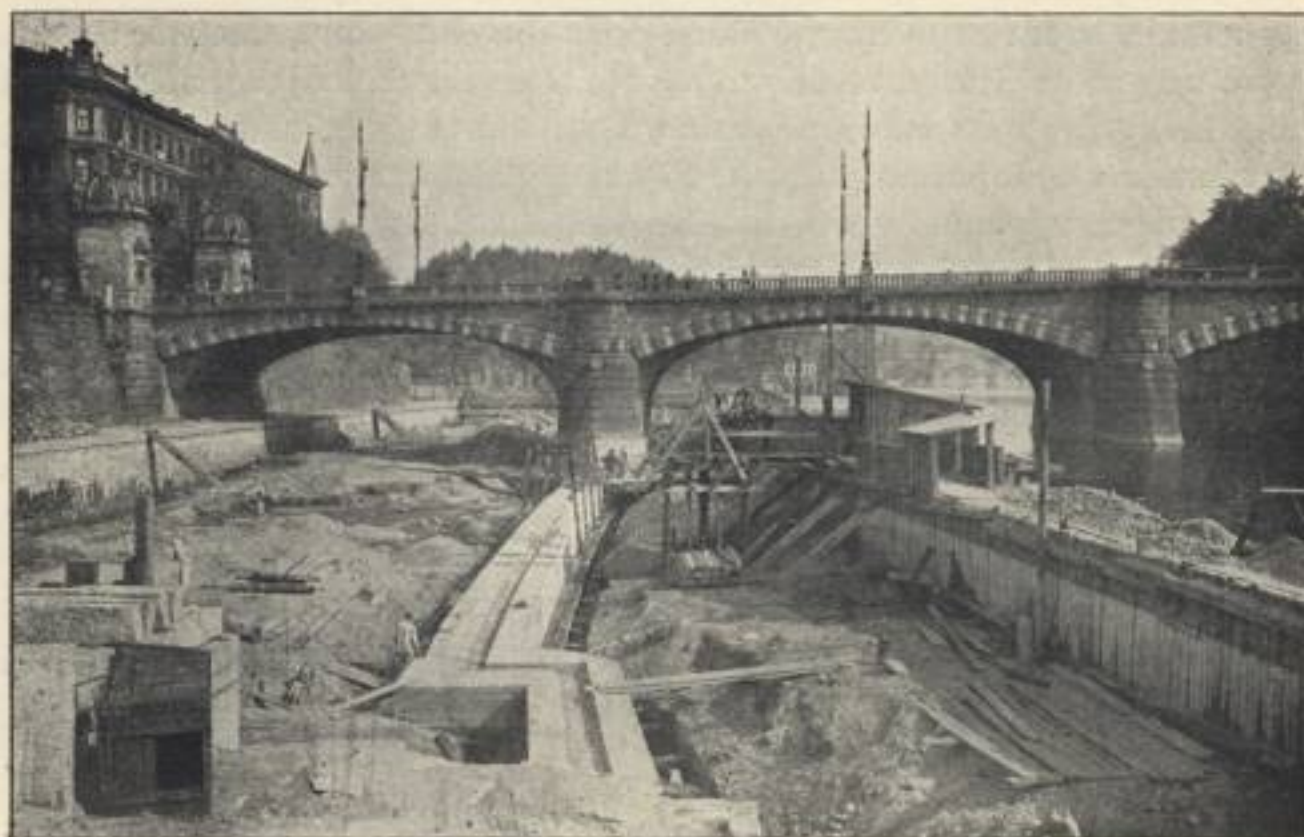
Obr. 33. Zdymadlo u Slovanského ostrova, 17. května 1918. Základy dělicí zdi pod vlakovým plavidlem.
