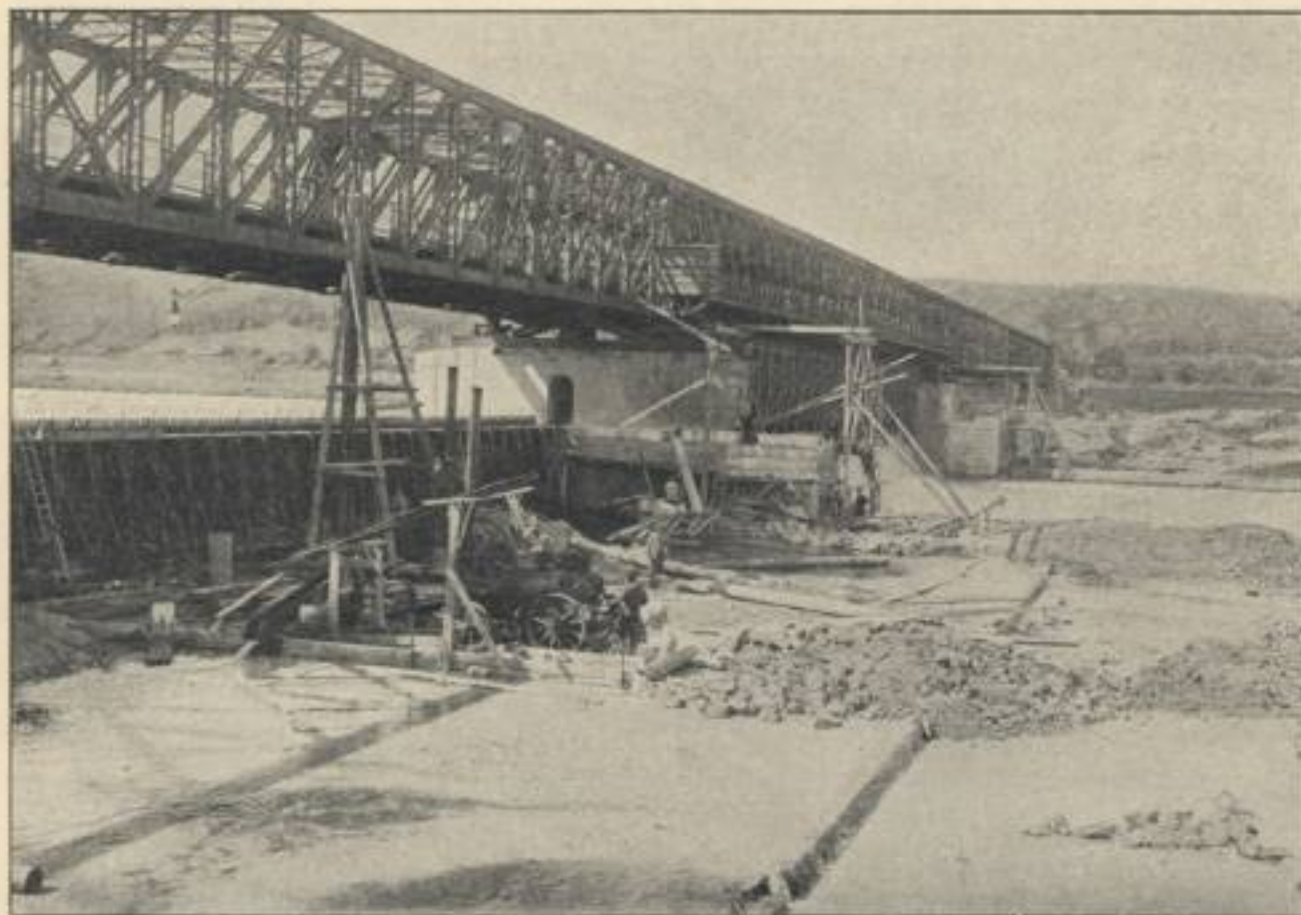
Obr. 57. Stavba válcového jezu v Miřejovicích. 28. srpna 1923.
