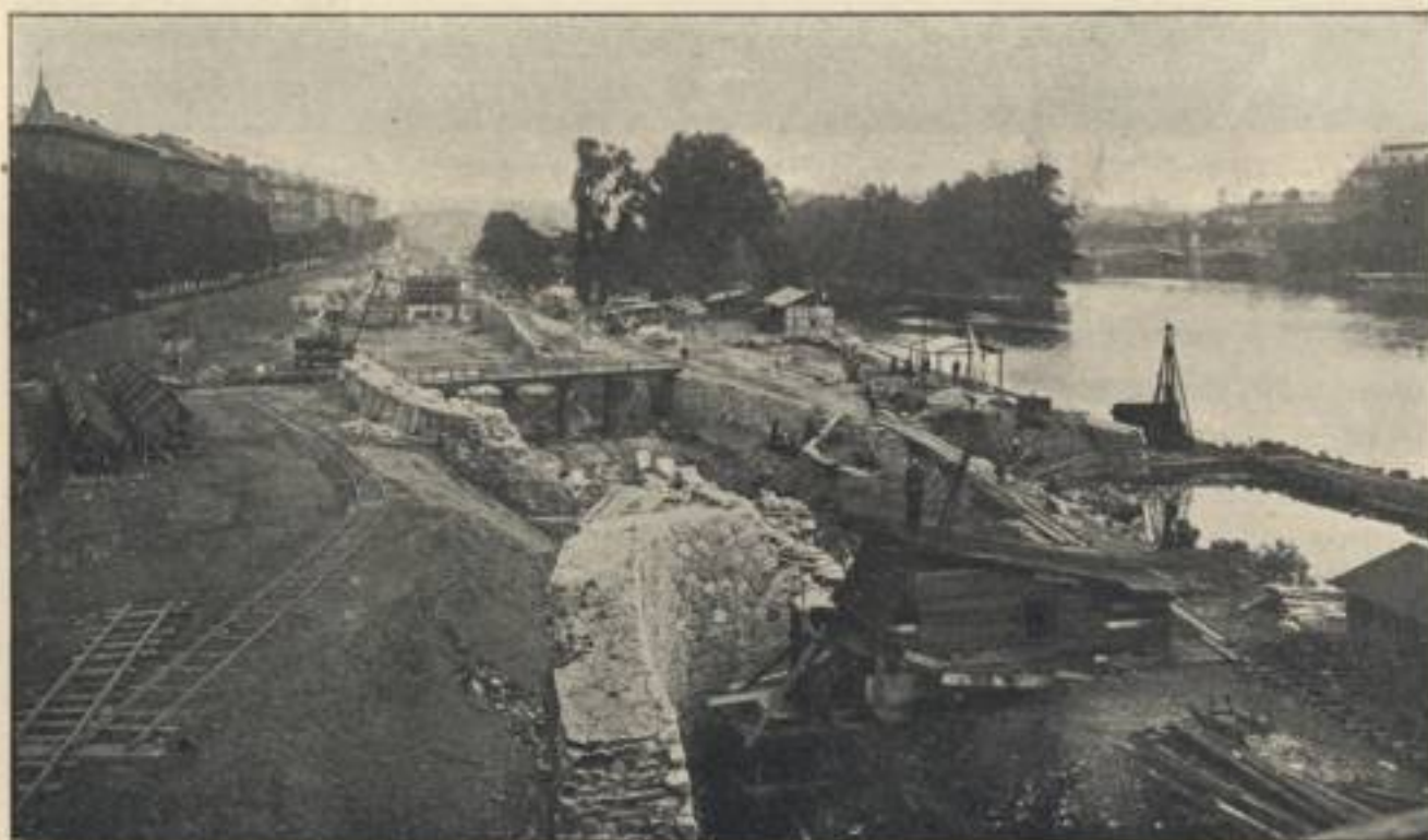
Obr. 26. Stavba uzavírky proti povodni, 7. srpna 1913.
