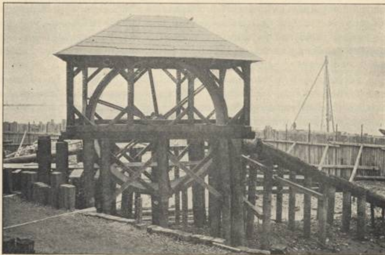
Obr. 23. Barborka, šlapací kolo zbavené bednění. 20. srpna 1913.
