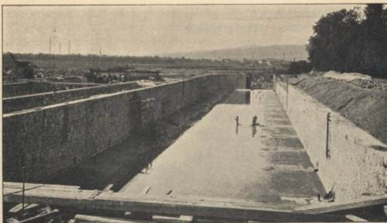
Obr. 4. Postup stavby komorových plavidel v Lovosicích. 16. září 1913.
