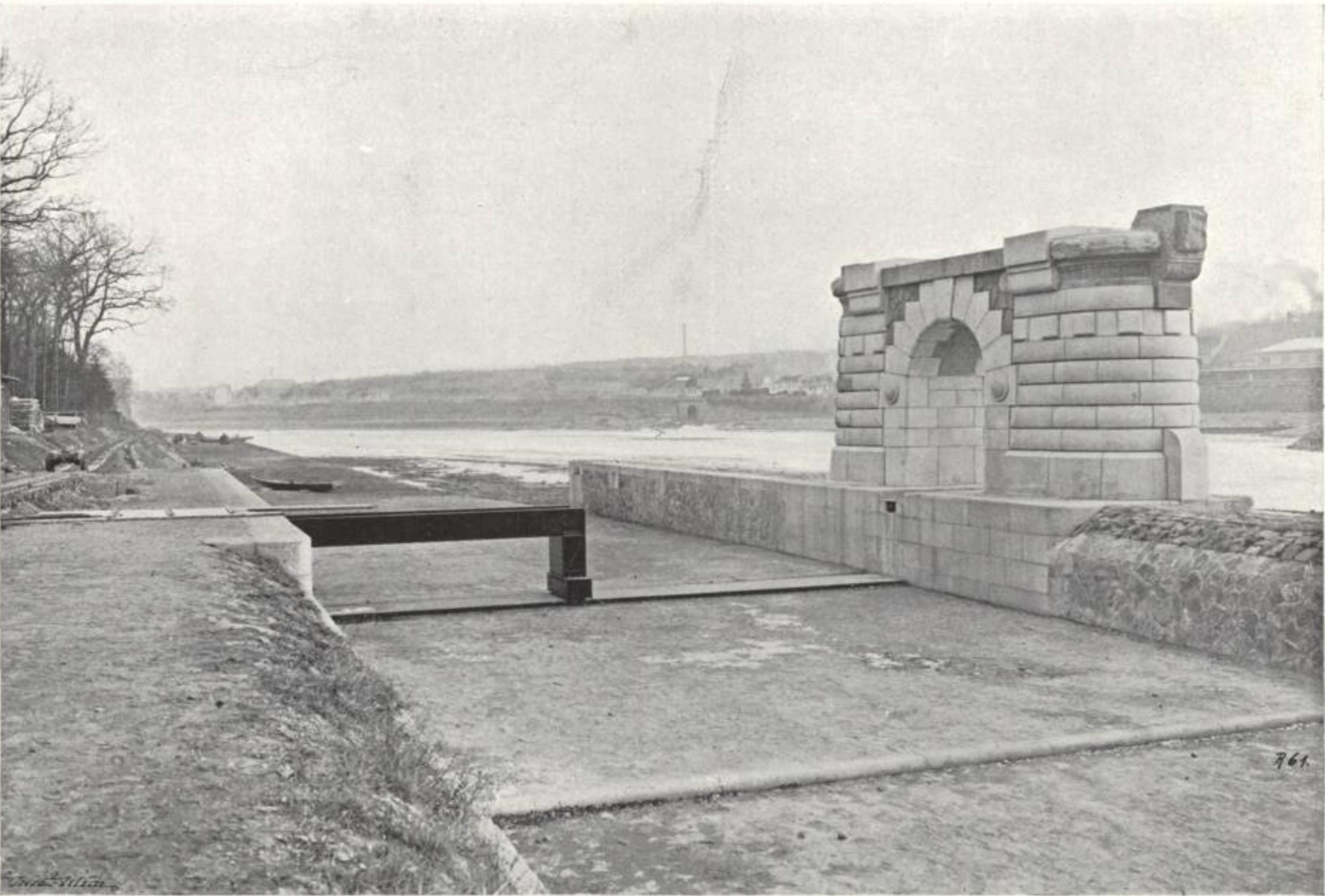
Obr. 9. Výsuvná lávka přes vorovou propust a pohled na jeden pilíř silničního mostu v Roudnici.
