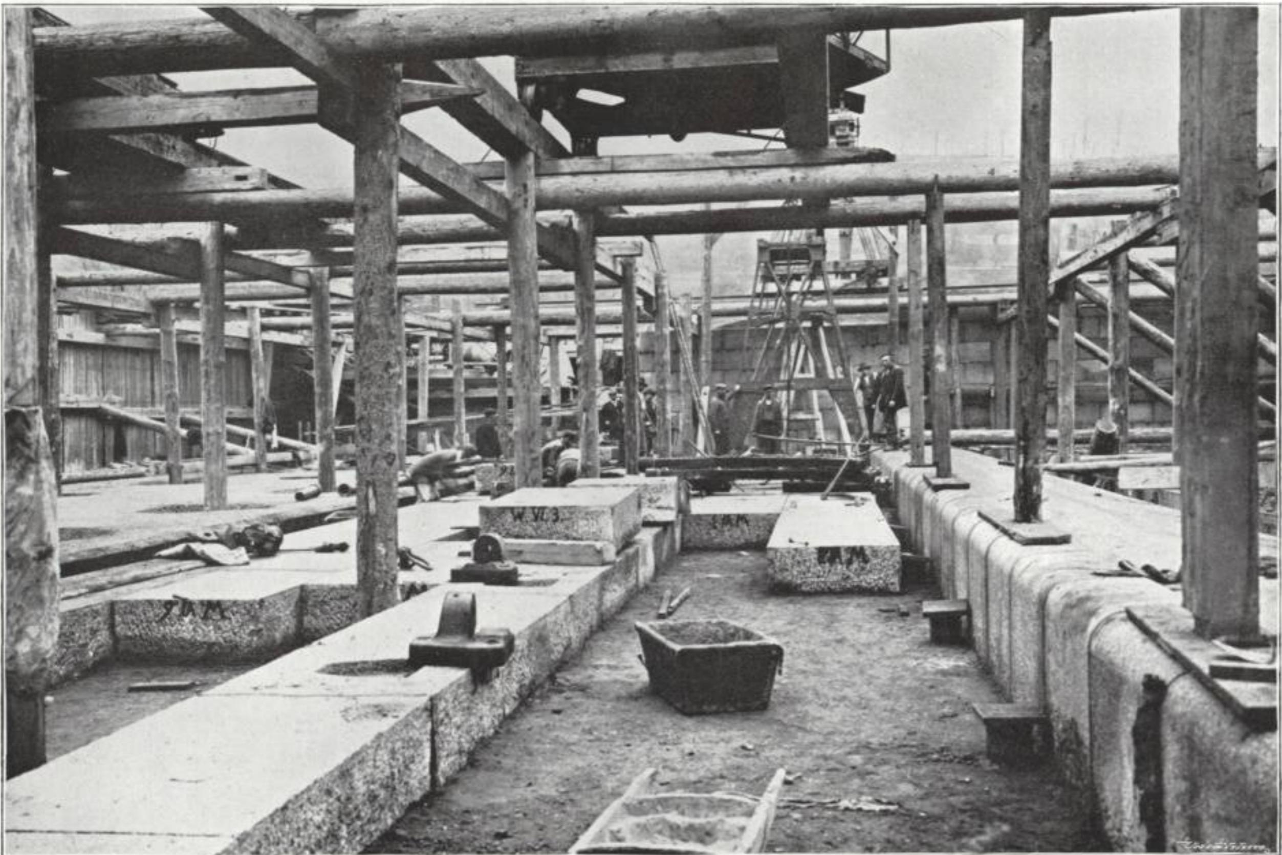
Obr. 5. Počátek prací montovacích v lodní propusti zdýmadla štětského.
