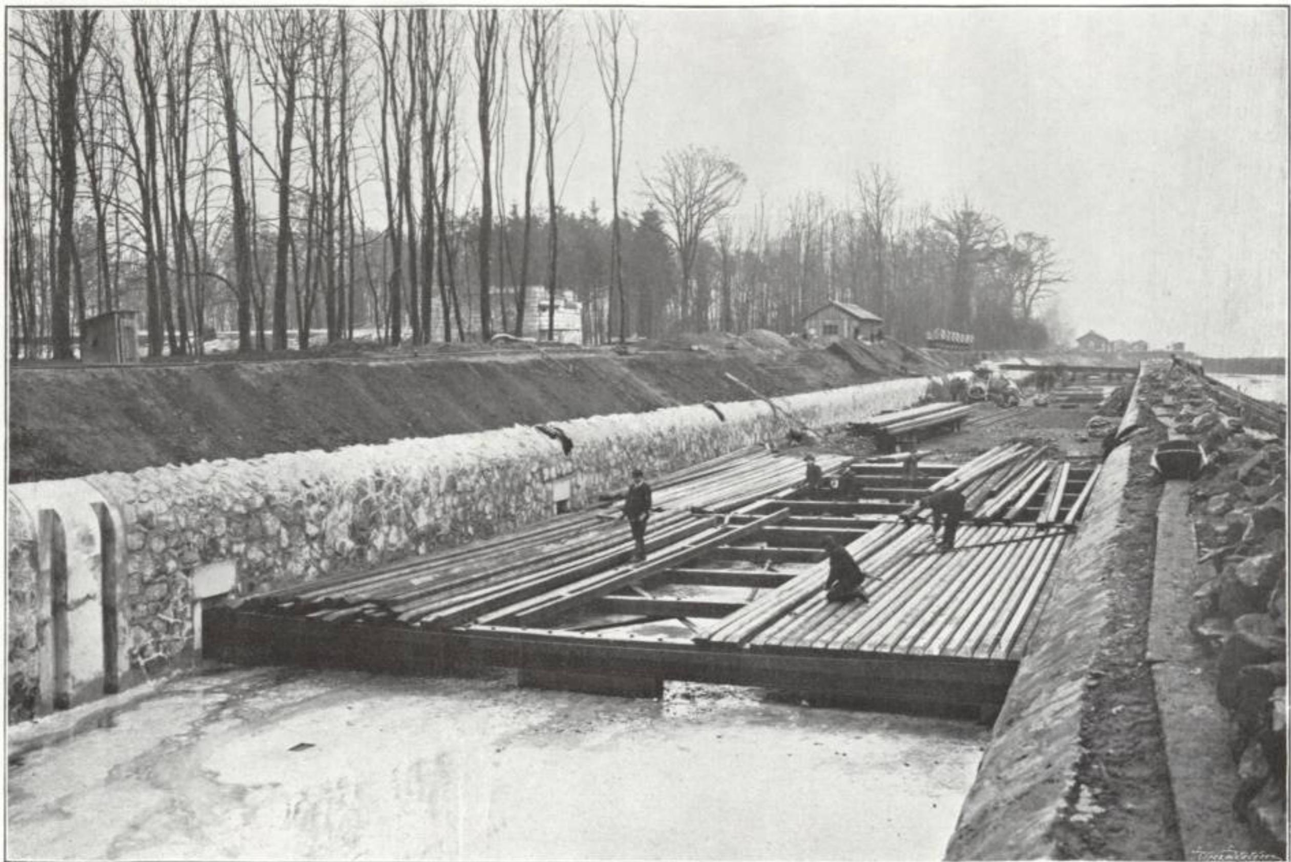
Obr. 12. Montáž klapaček ve vorové propusti u Roudnice.
