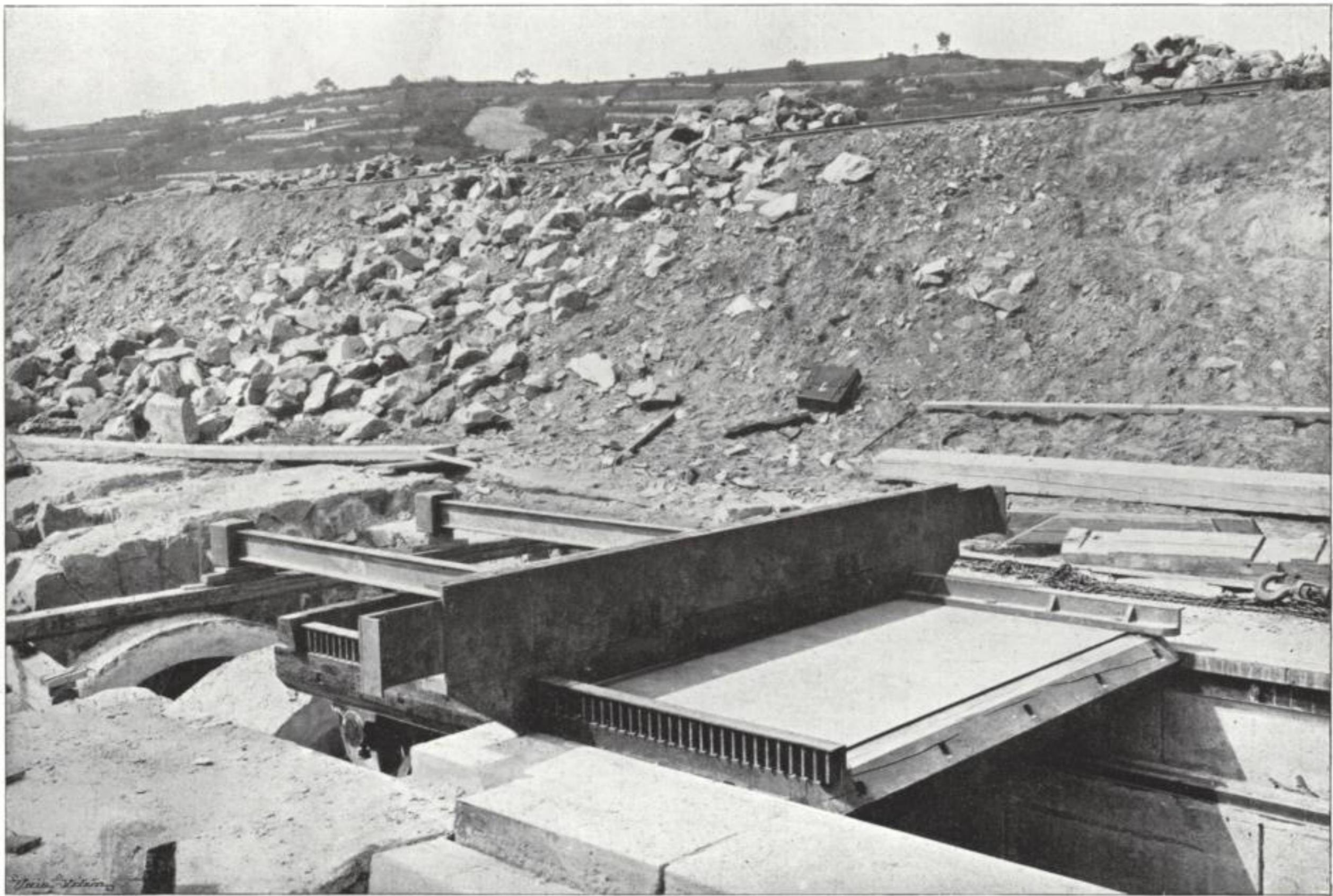
Obr. 9. Pohled na horizontální stavidlo před vybetonováním šachty.
