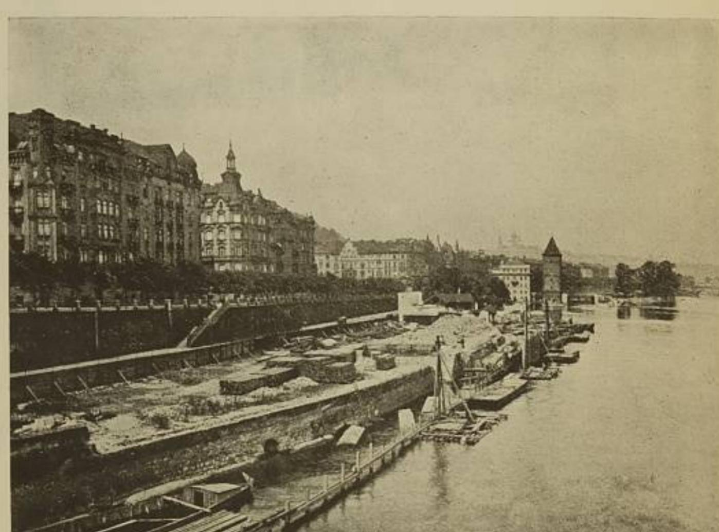
Obr. 23. Stavba nábřeží na Smíchově. Jimka II. pod mostem Palackého.
