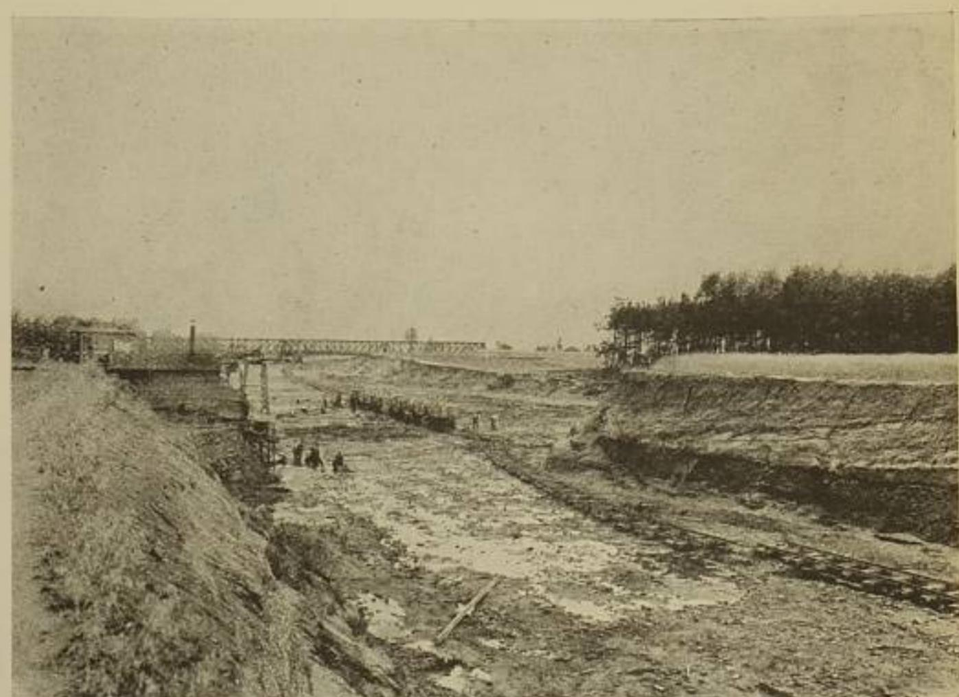
Obr. 21. 2. července 1915. Neratovice: Výkop pro komorové plavidlo. Pohled na práce v průkopu nad neratovickým mostem; výkop skály.
