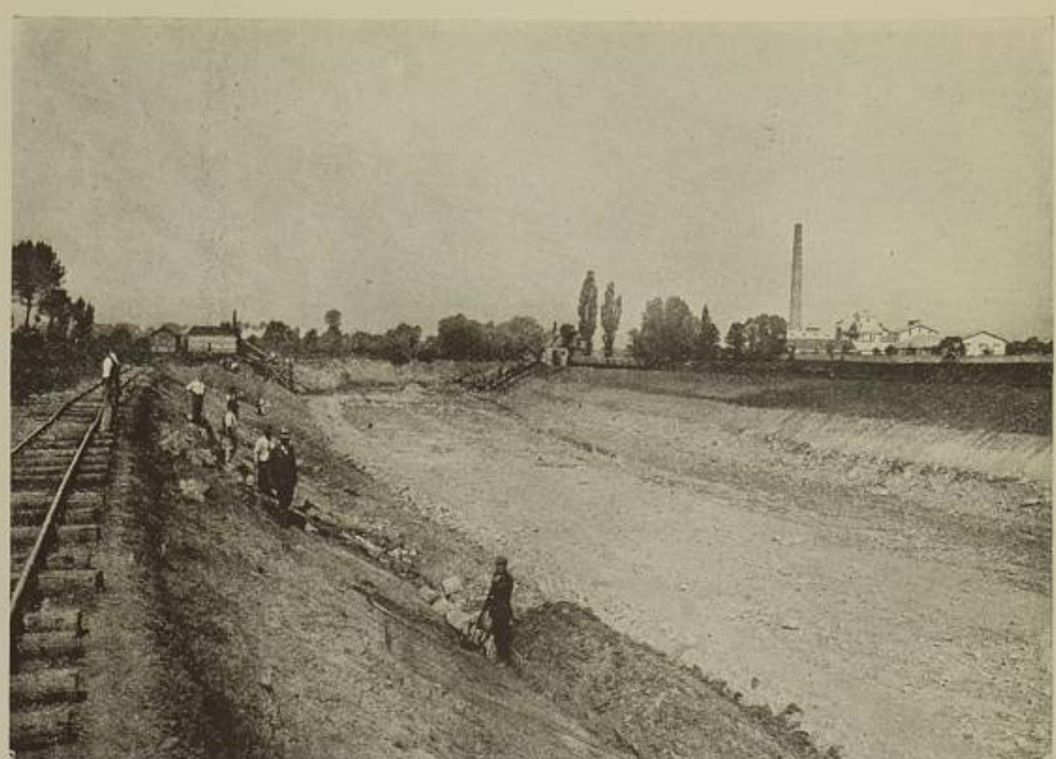
Obr. 14. Poděbrady: Práce na průkopu nad cukrovarem.
