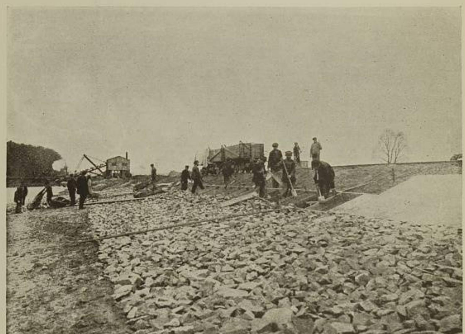
Obr. 15. 10. listopadu. Nymburk: Betonování svahu pravého břehu a opevňování báňku skalními úlomky u průkopu na Rohově (u prof. č. 18.).
