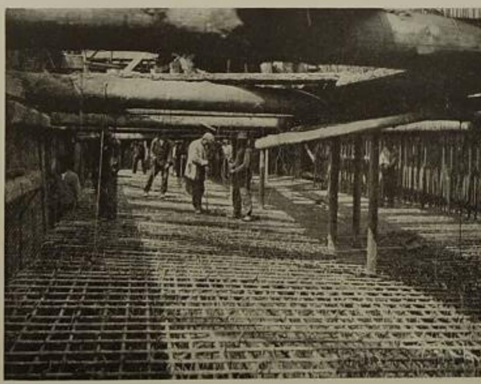
Obr. 11. Kolín: Armatura základní desky pro pilíř V.
