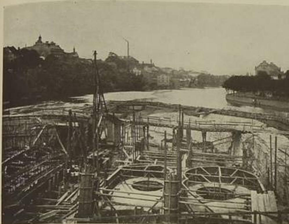
Obr. 12. Kolín: Pohled na betonové turbinové kašny.
