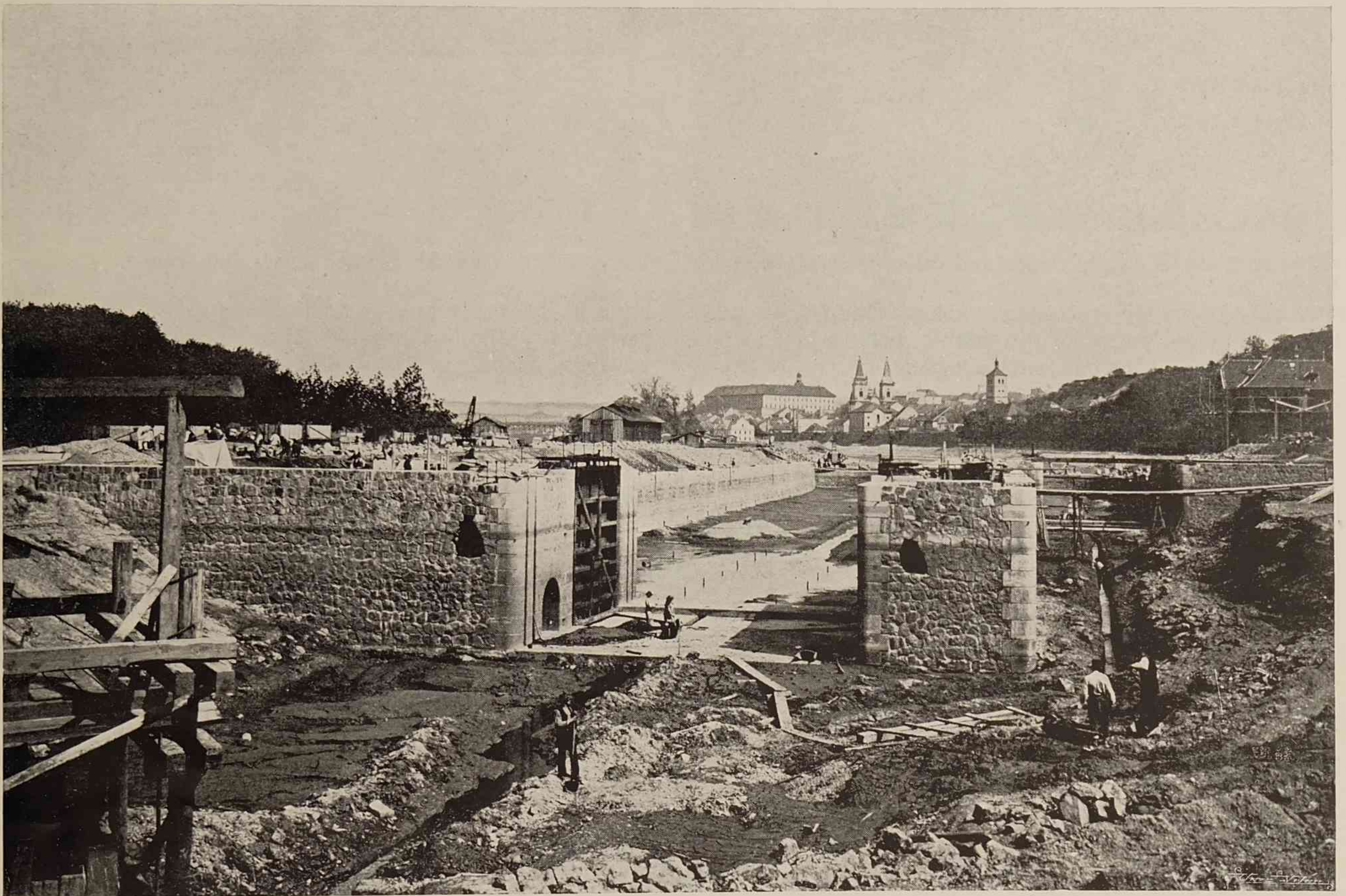
Obr. 18. Stavba komor plavidlových.
