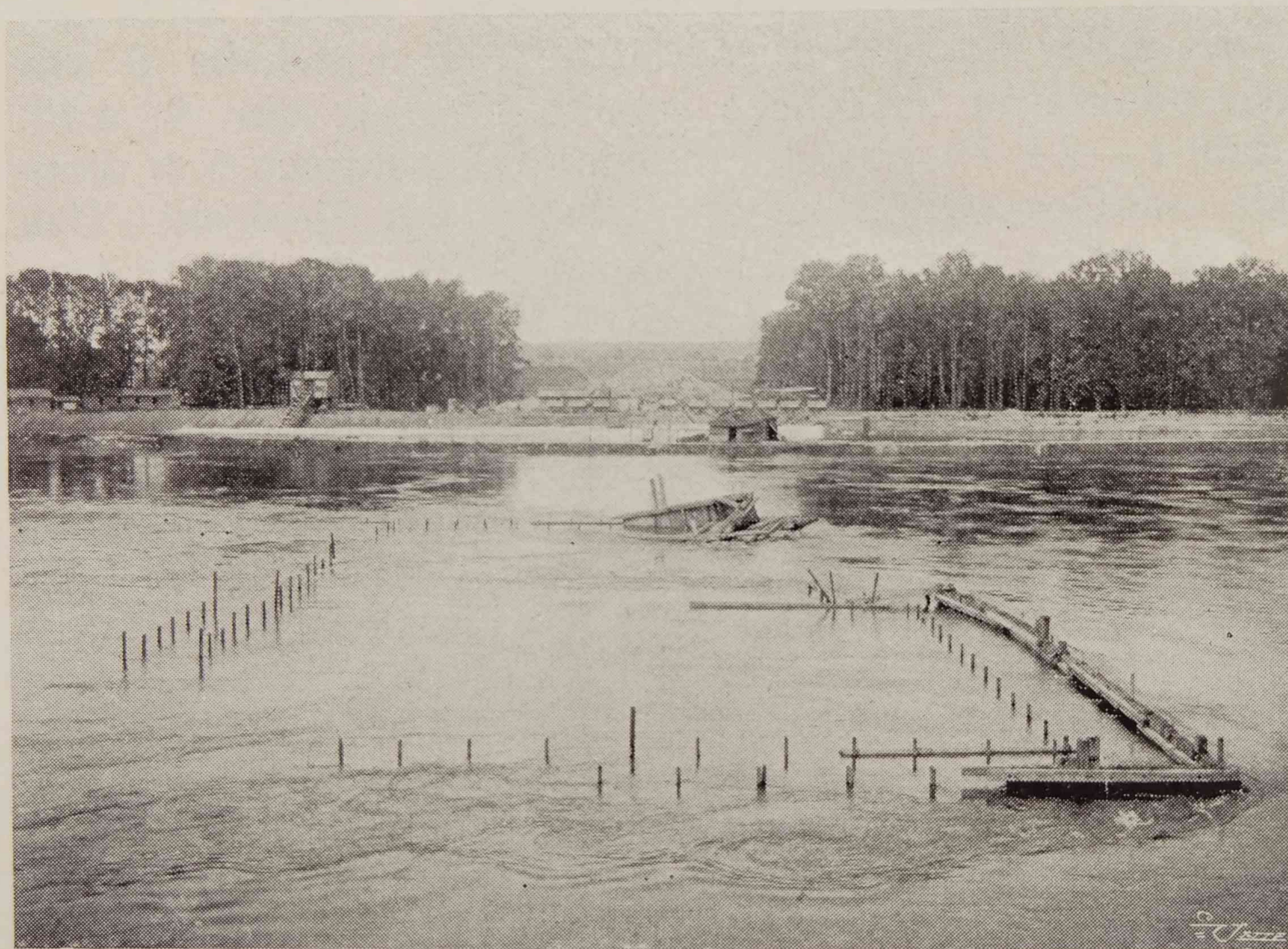
Obr. 17. Počátek stavby jimky druhého oddílu jezového za velké vody 17. června 1907.
