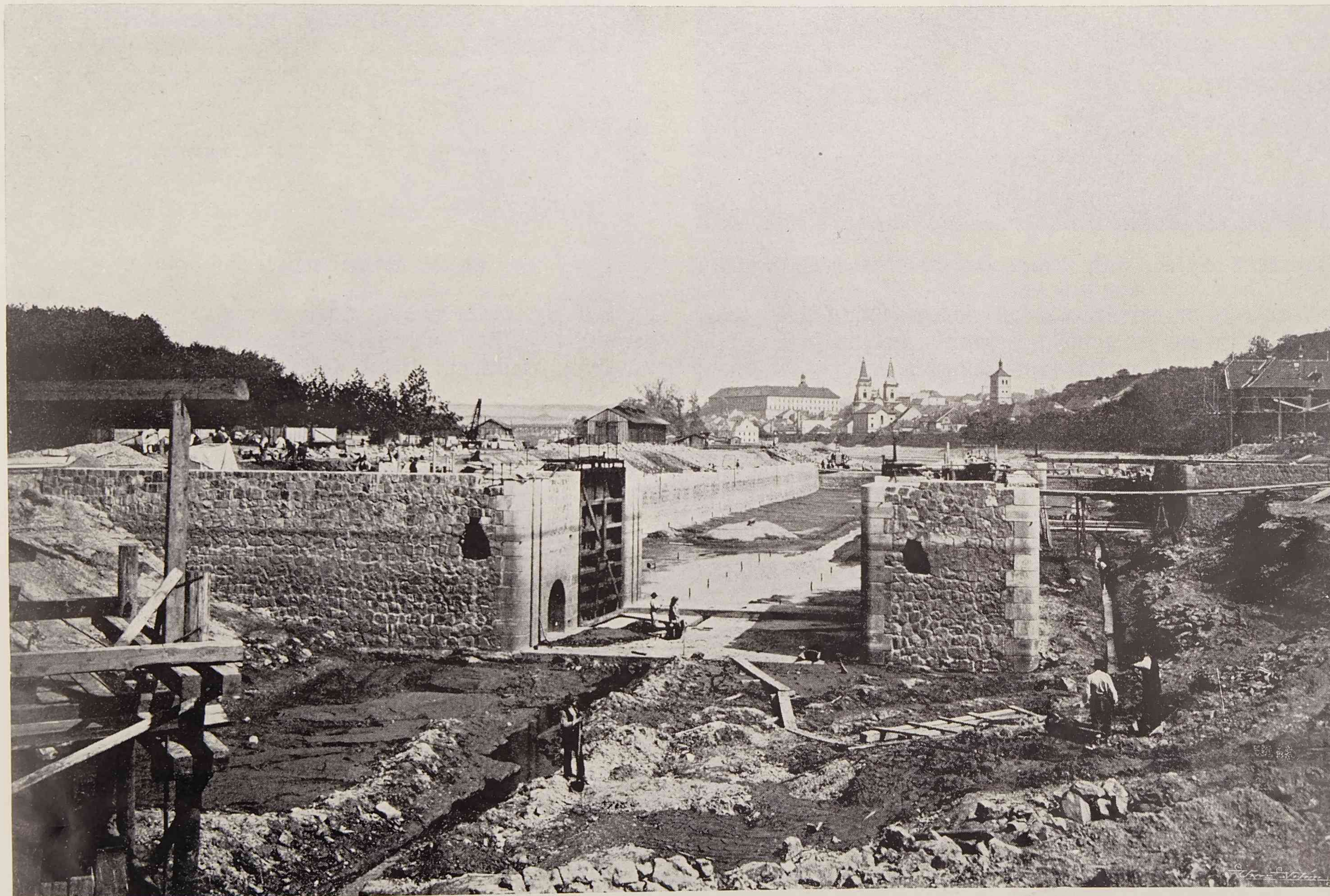
Obr. 18. Stavba komor plavidlových.
