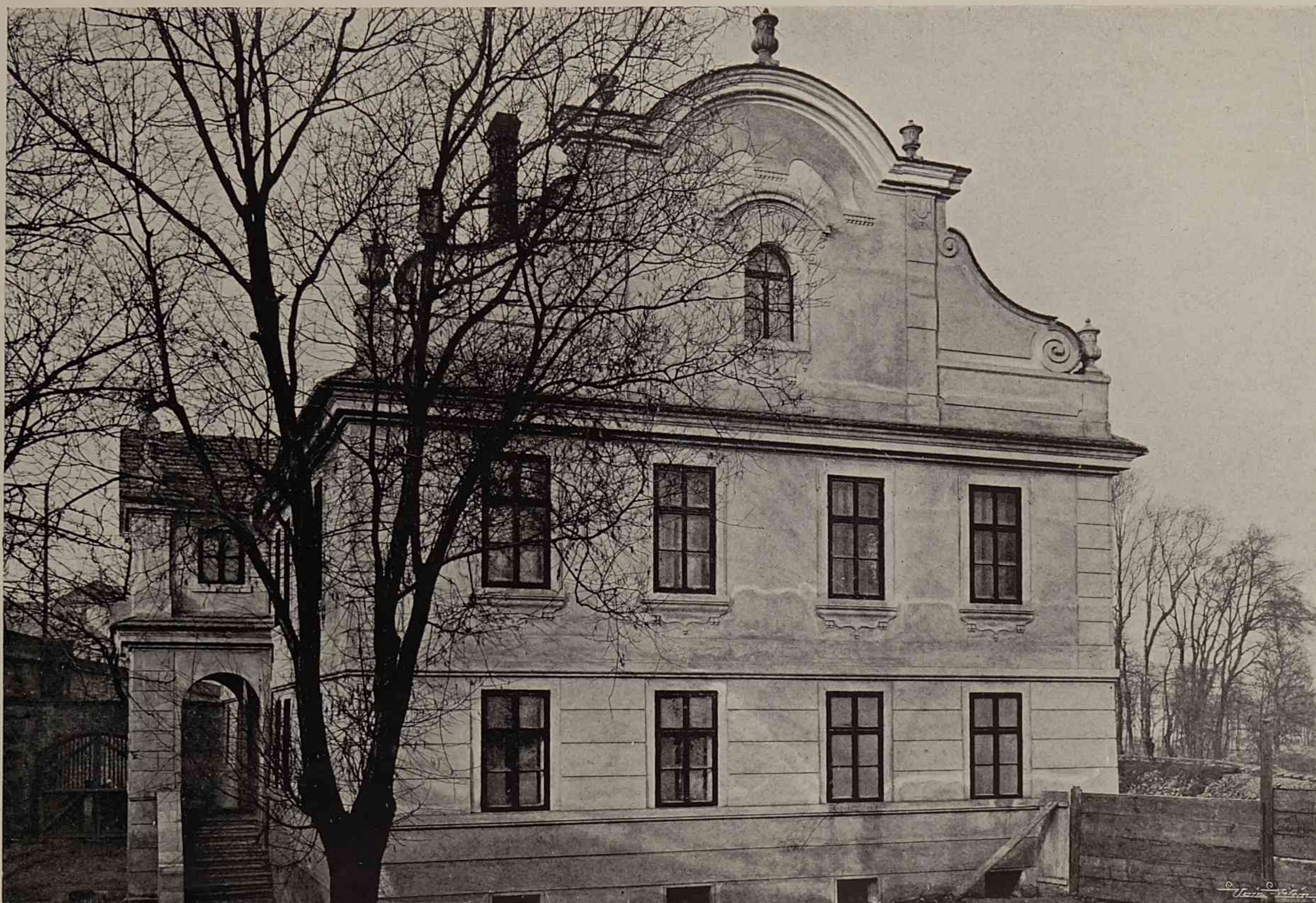
Obr. 8. Přestavěná budova mlýnská.
