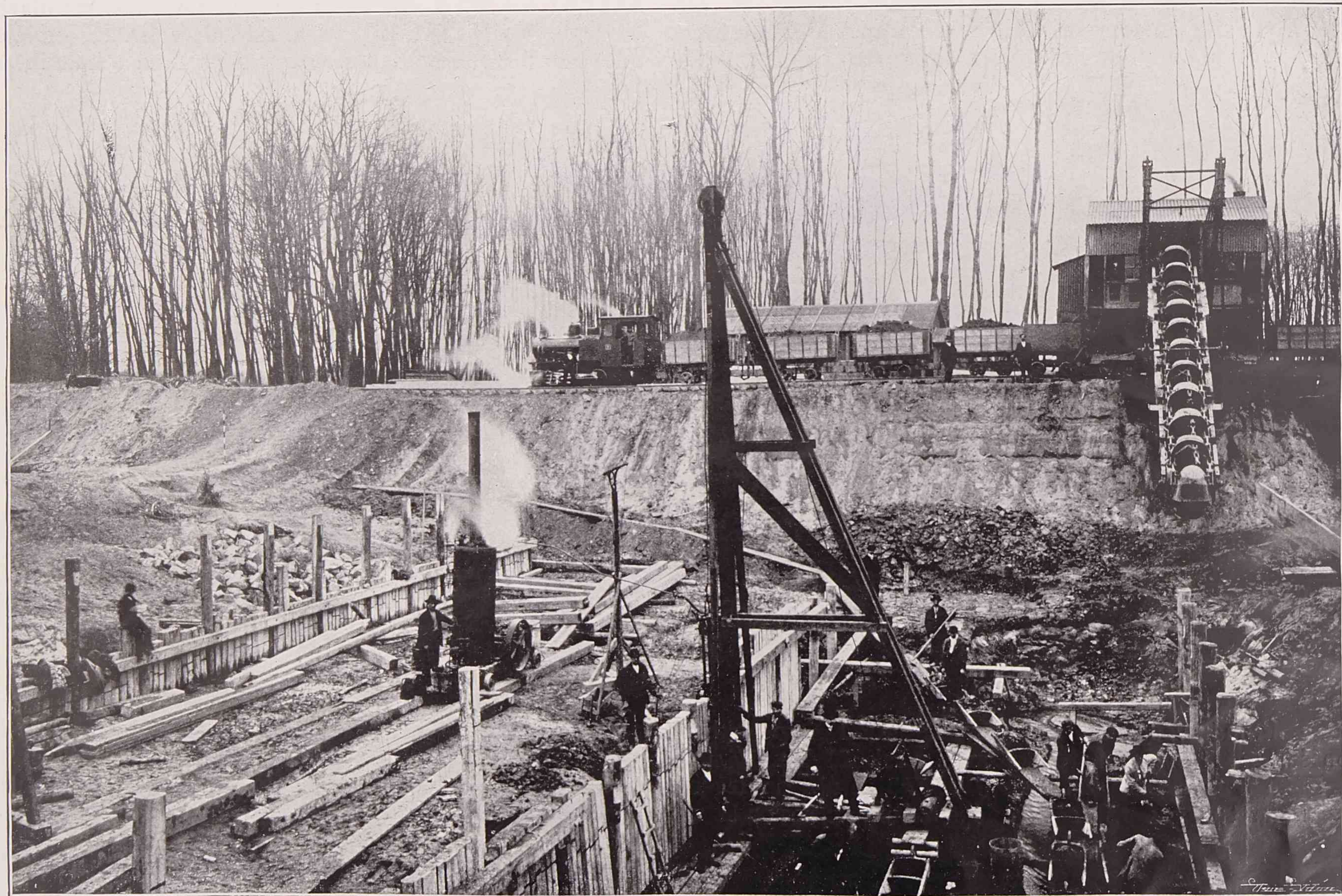
Obr. 3. Zakládání pravého pole jezového.
