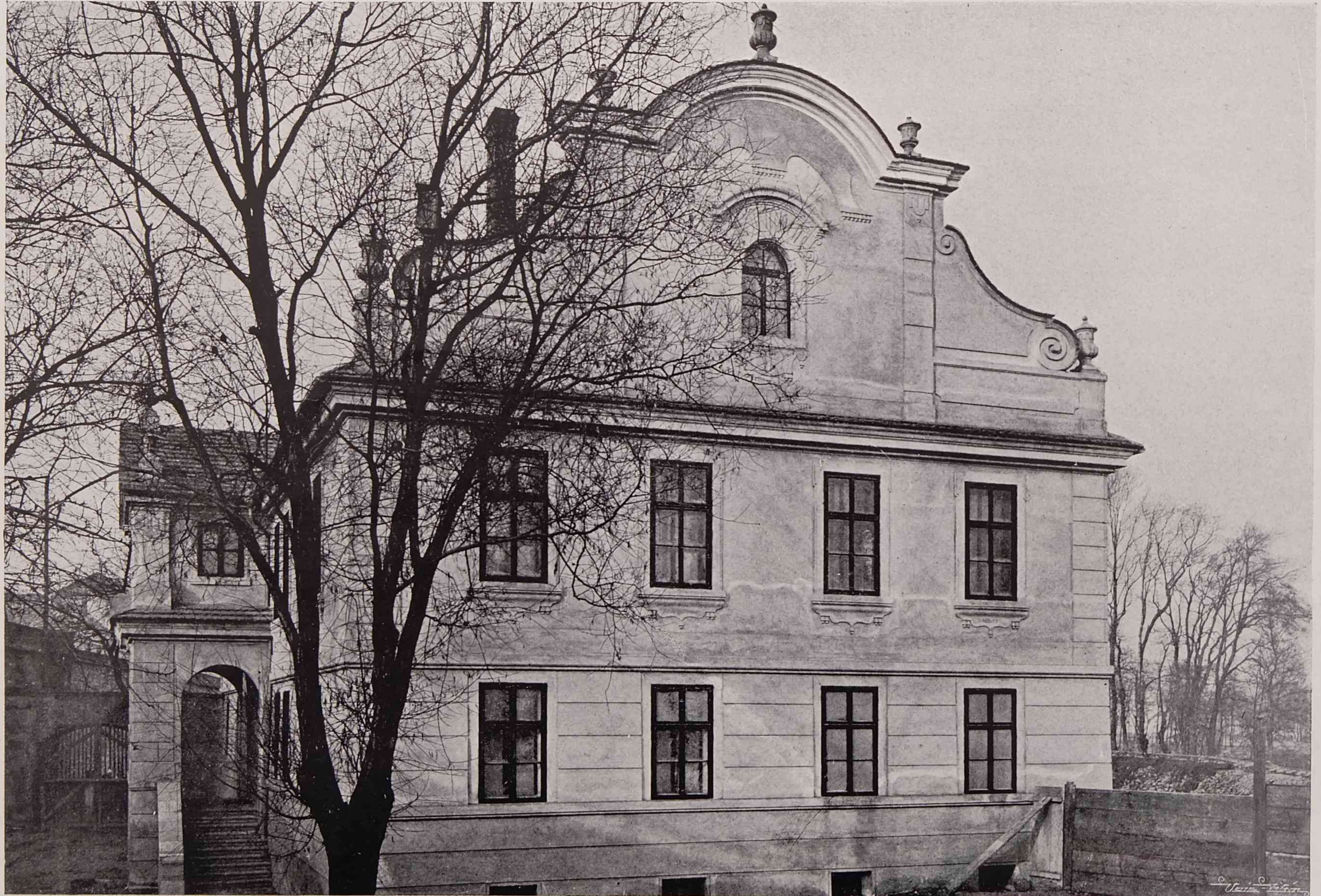
Obr. 8. Přestavěná budova mlýnská.
