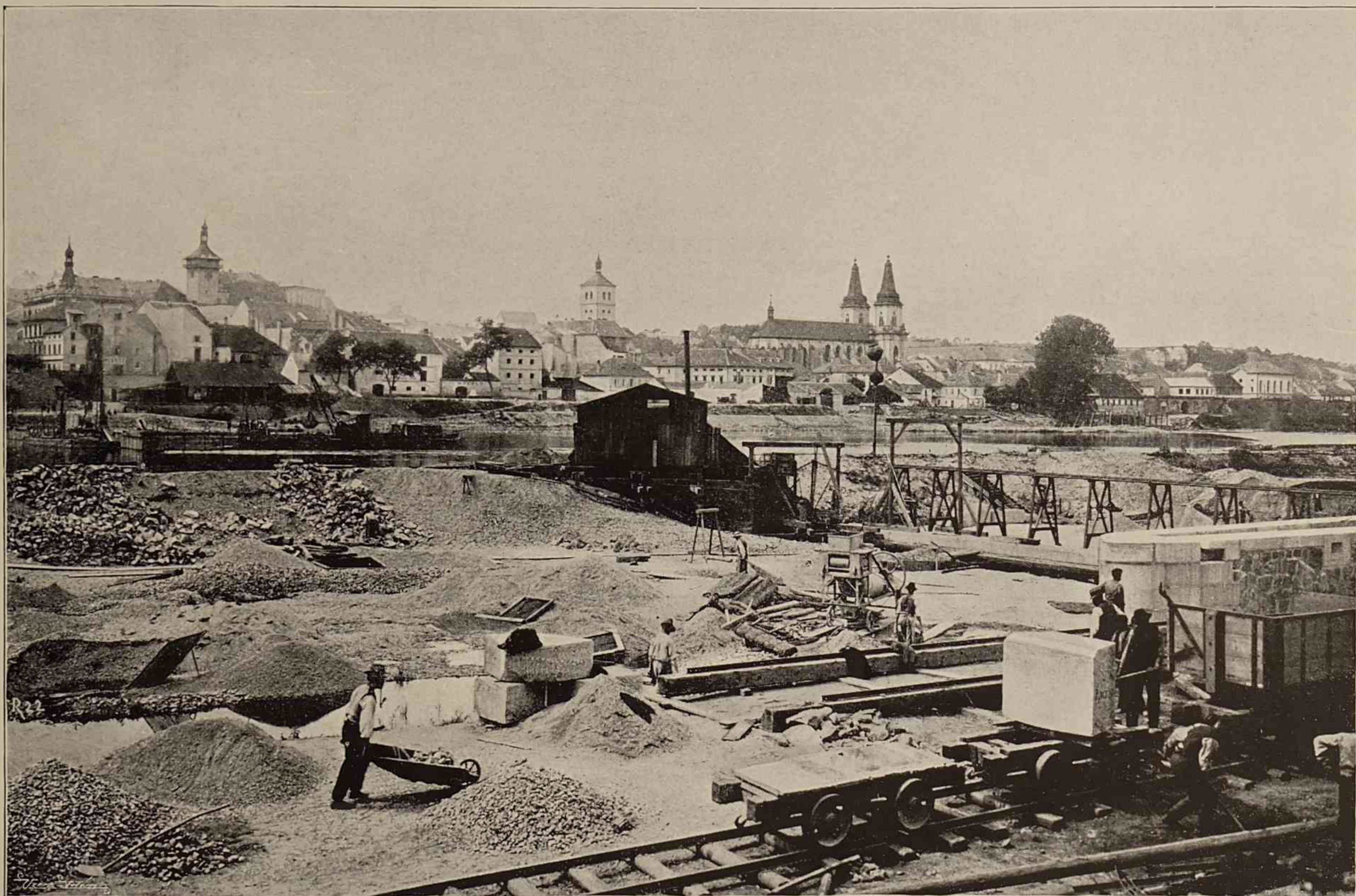
Obr. 13. Zakládání prvního dílu jezového.
