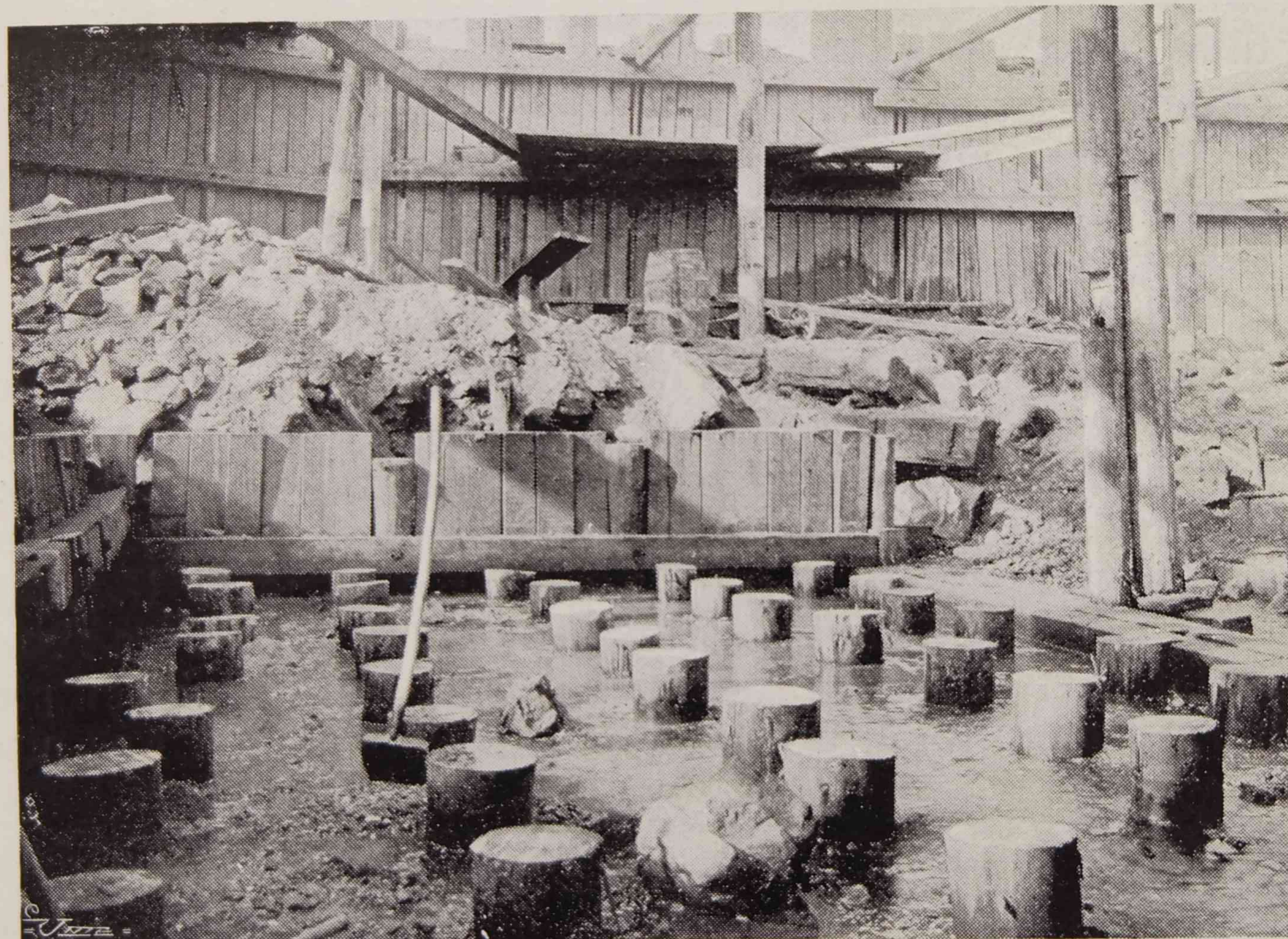
Obr. 11. Základ mostového pilíře čís. 4.
