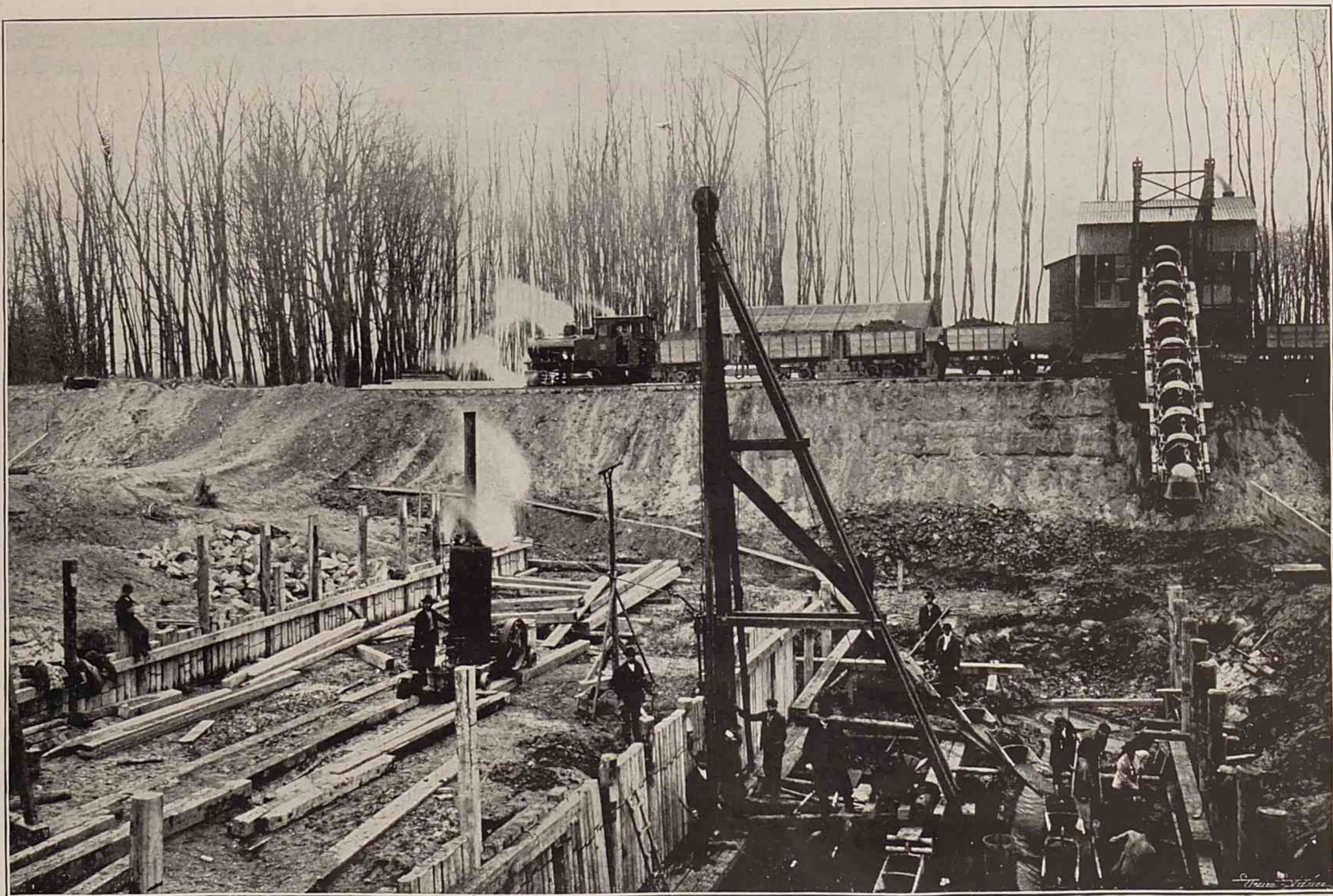
Obr. 3. Zakládání pravého pole jezového.
