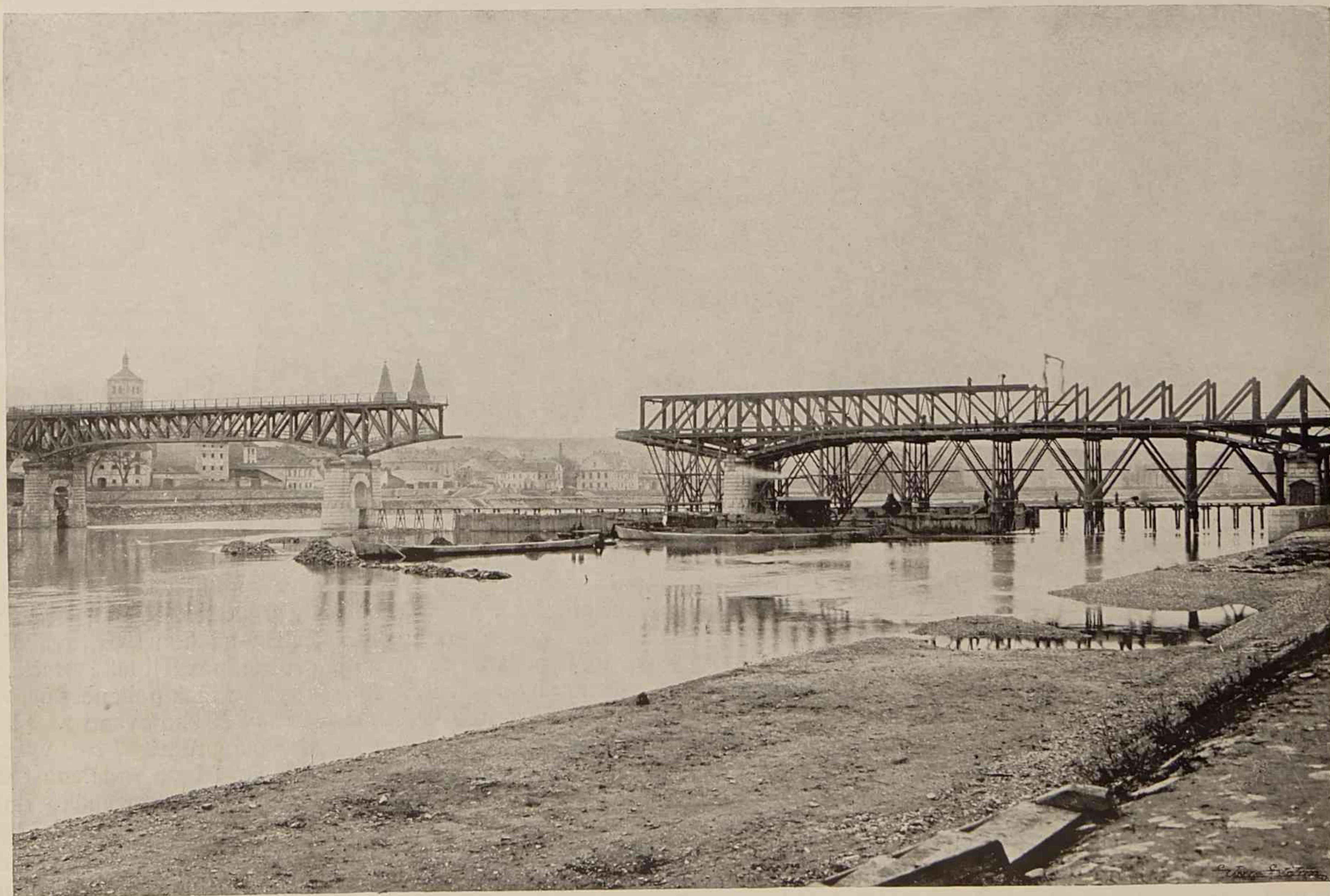
Obr. 20. Montáž mostu přes řeku.
