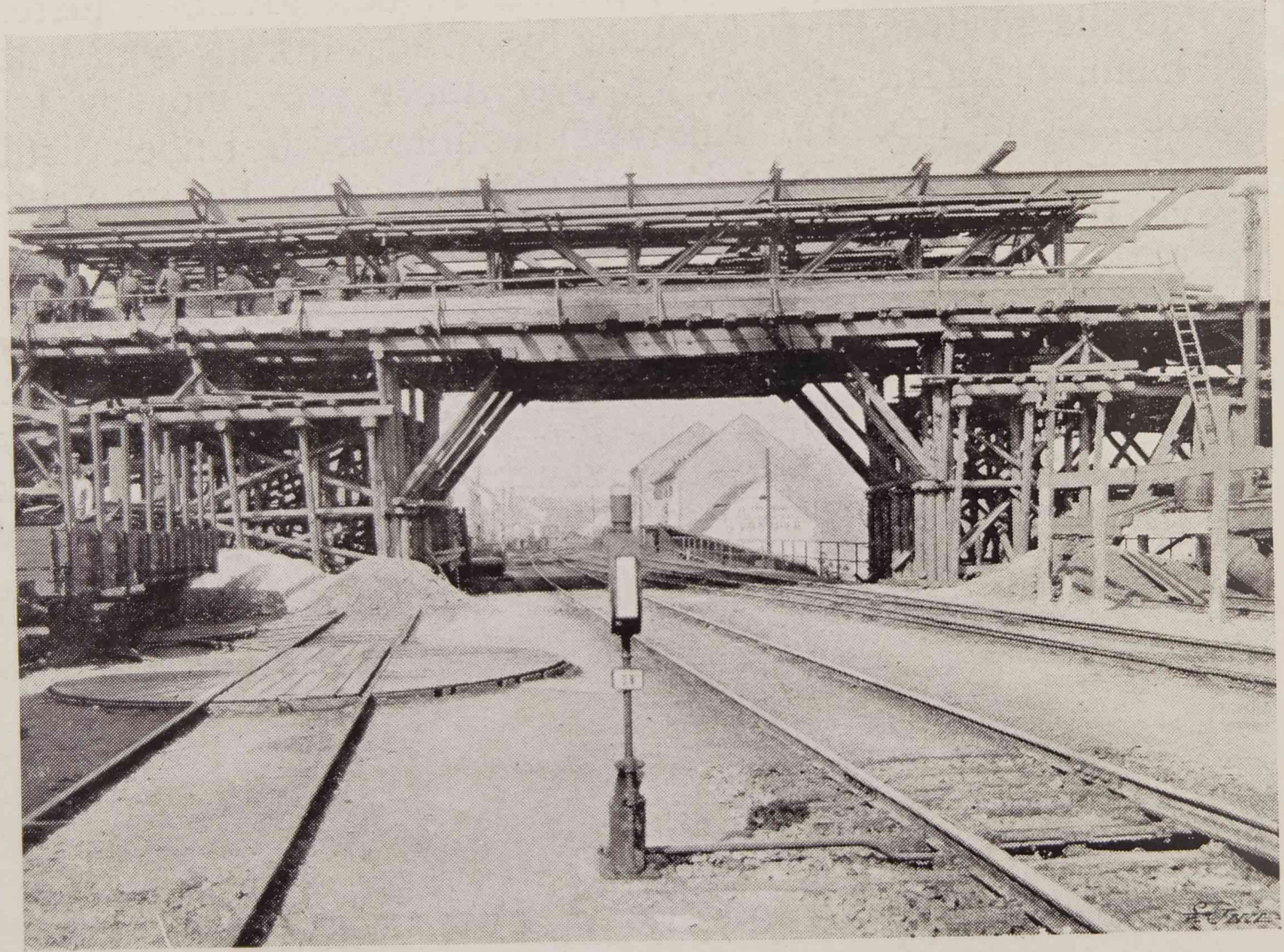
Obr. 21. Montáž mostu nad dráhou.
