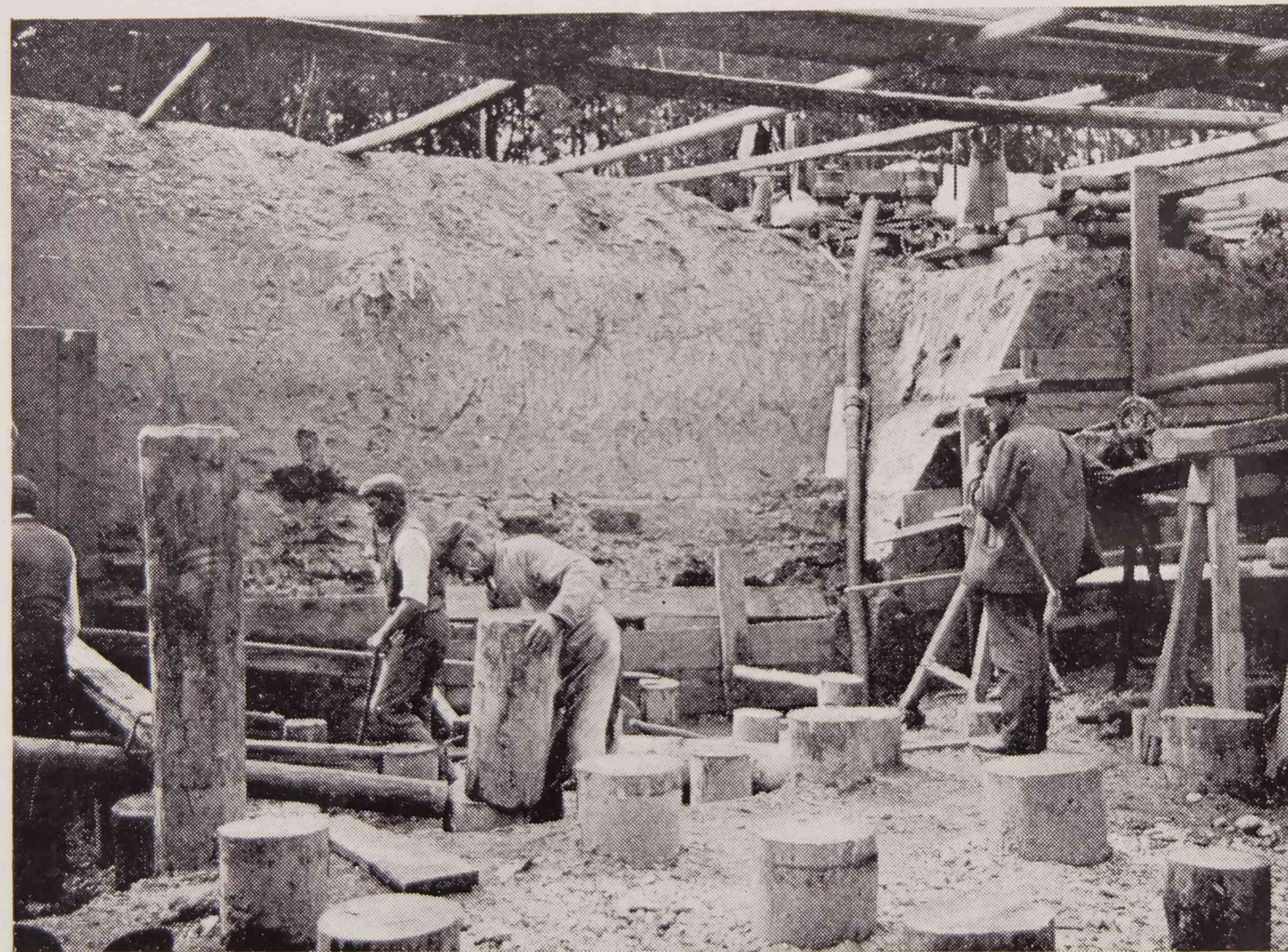
Obr. 12. Základ pravého pilíře pobřežního čís. 8.
