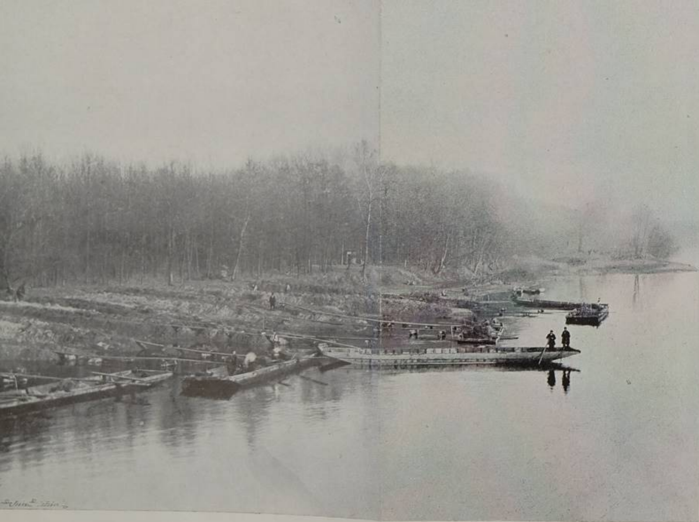
Obr. 12. Úprava u Obříství 1. prosince 1908. Pohled na úpravu pravého břehu, starého řečiště labského pod průkopem, a na stroje, hrázku mezi průkopem a řečištěm prorážející.
