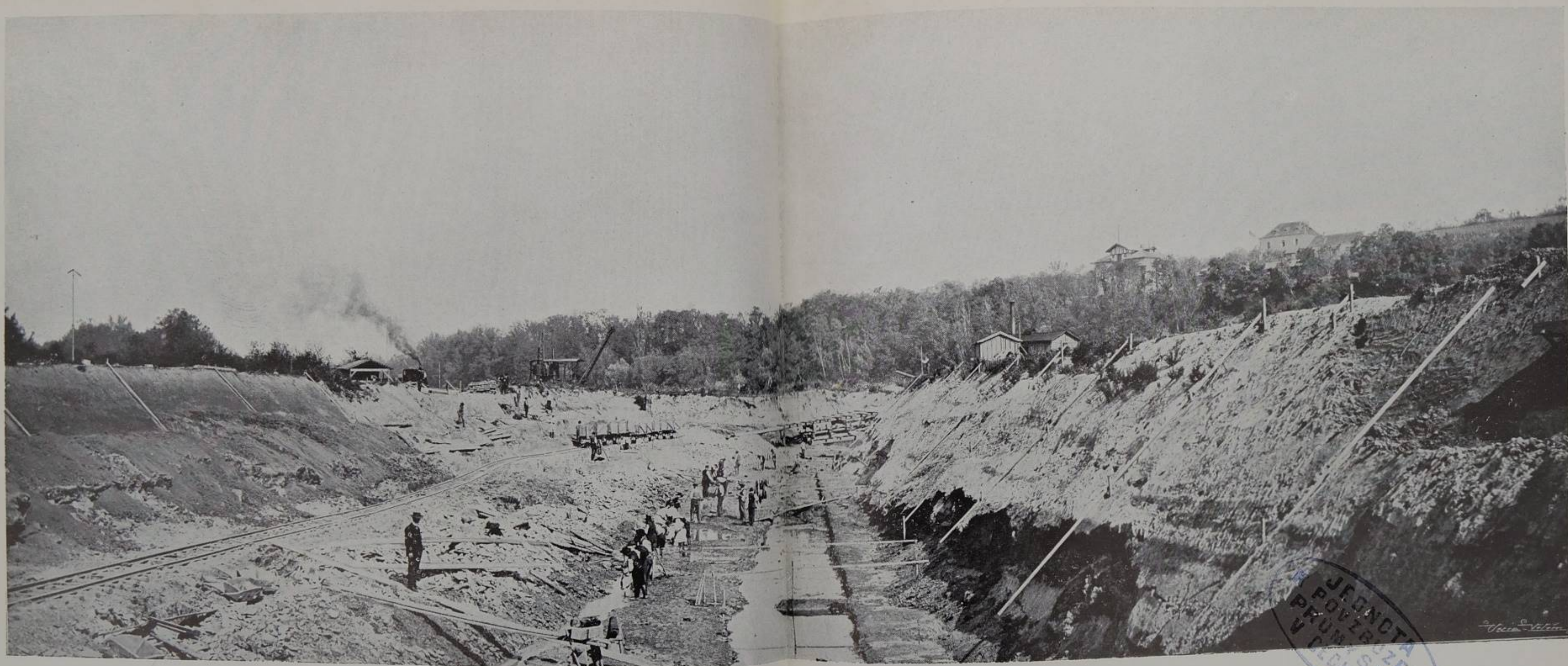
Obr. 16. Úprava u Mělníka 9. září 1908. Výkop v plavidle. Pohled s horního shlaví směrem po vodě.
