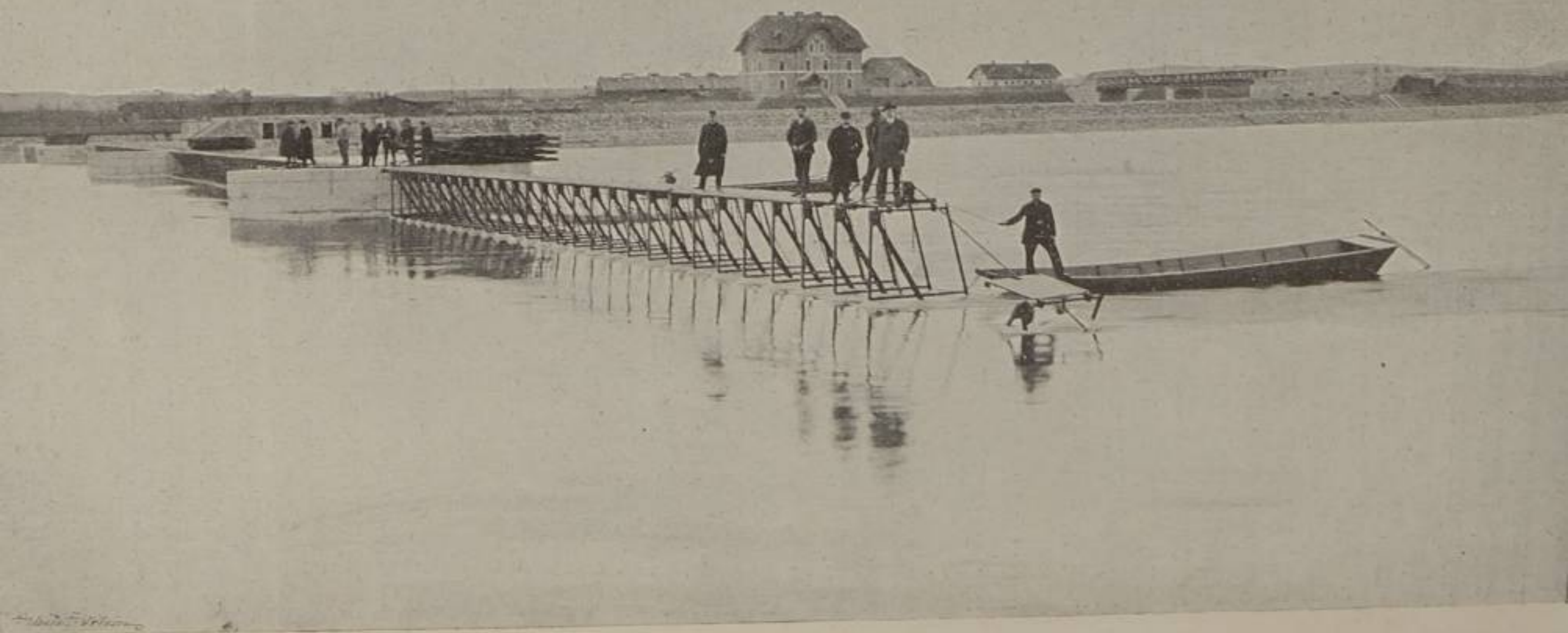
Obr. 1. Stavění hradlového jezu v Dol. Beřkovicích dne 11. března 1908.
