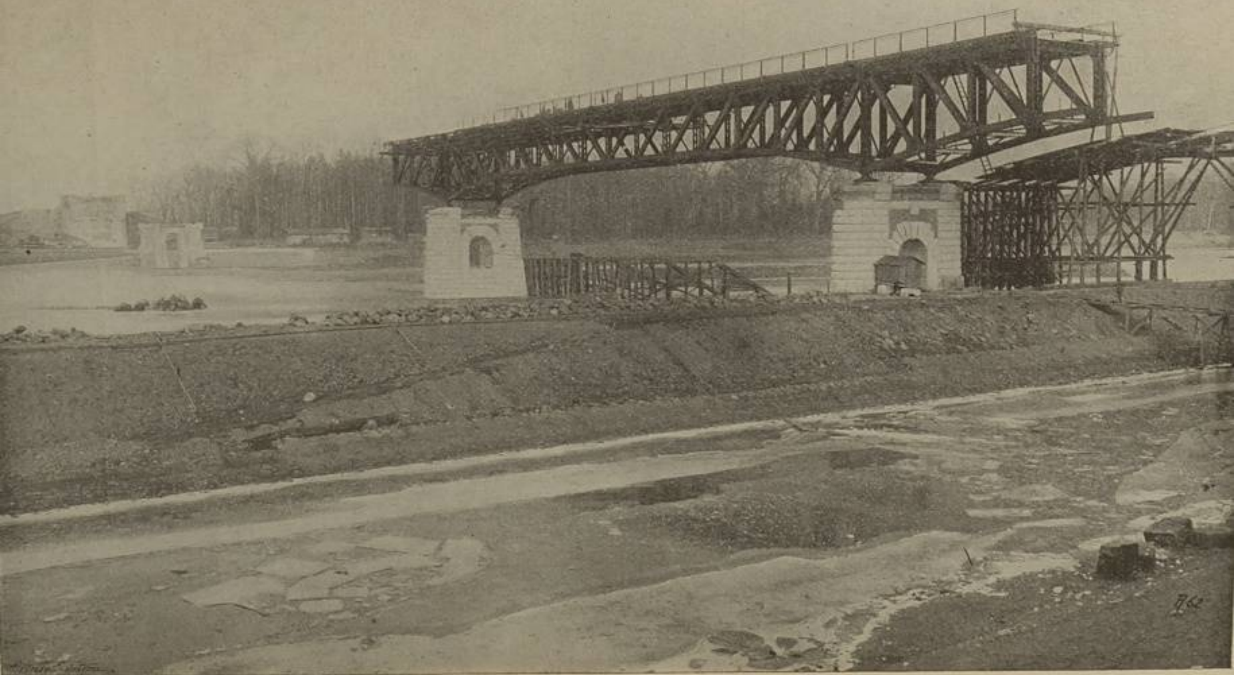
Obr. 6. Pohled na zmontované pole mostu přes lodní propust jezu v Roudnici.
