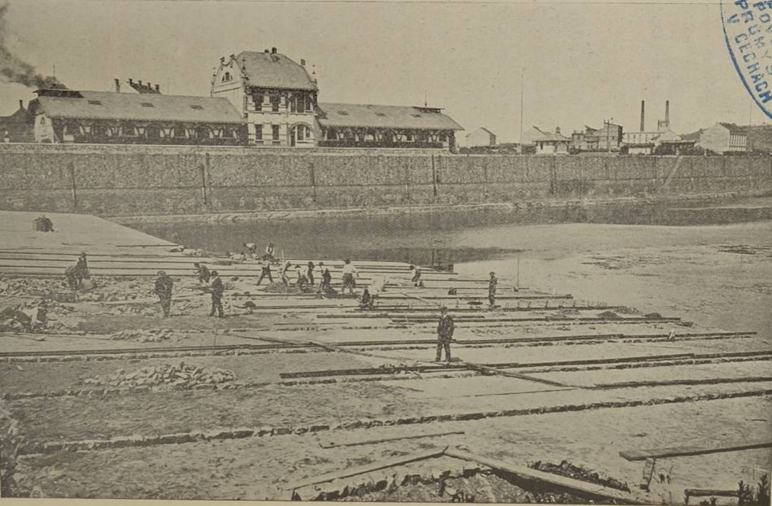
Obr. 10. Stavba loděnice v holešovickém přístavu.
