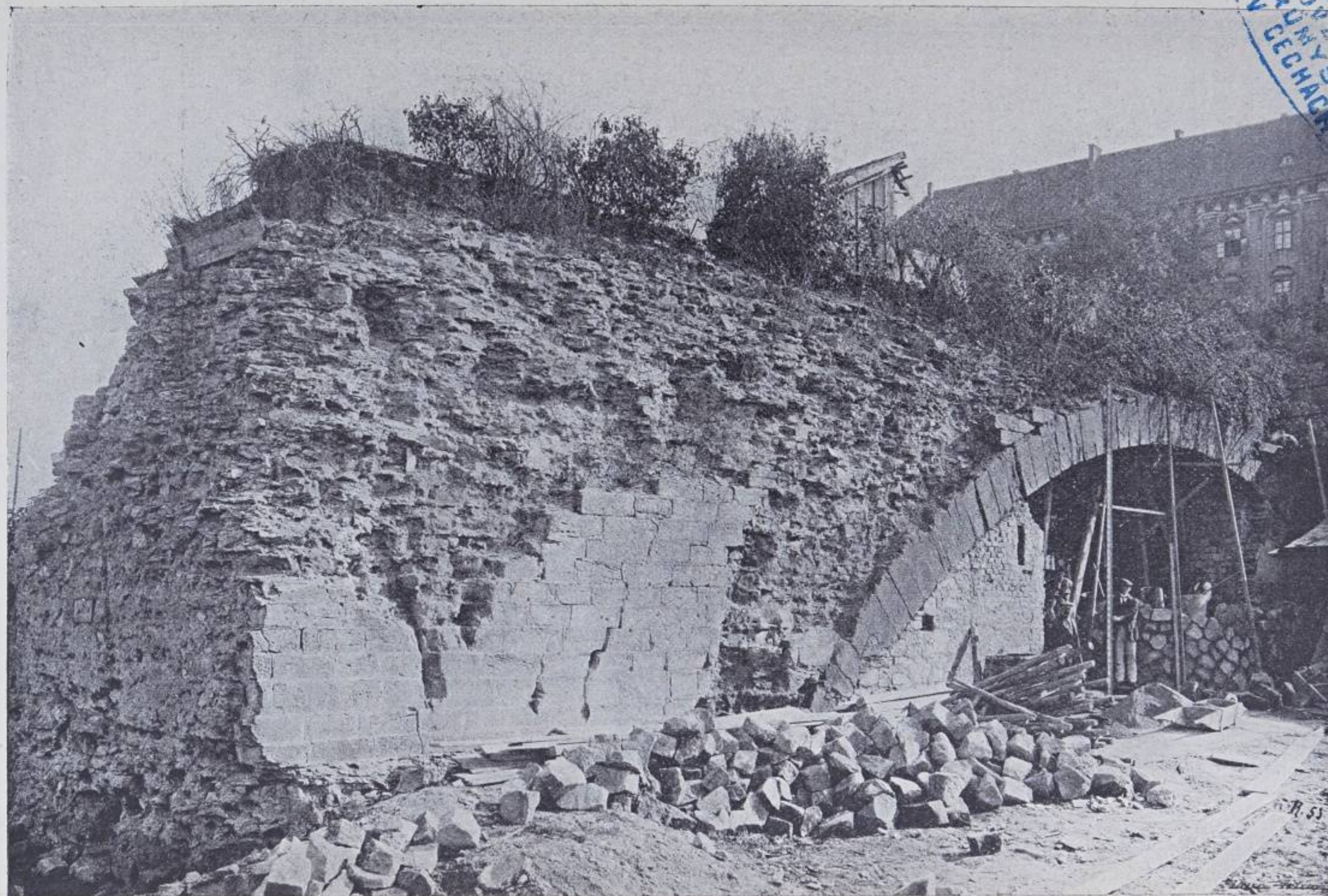
Obr. 5. Pohled na zbytky bývalého kamenného mostu v Roudnici před jich demolováním.
