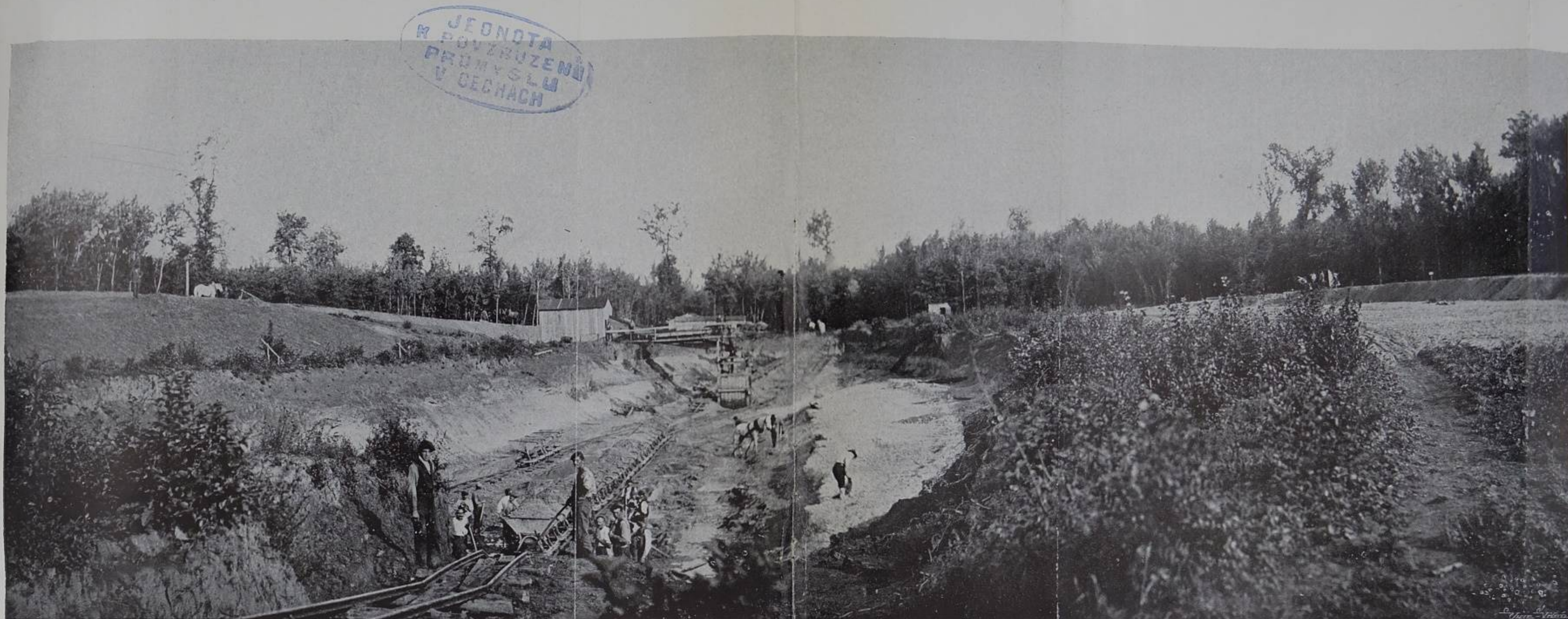
Obr. 13. Úprava u Obříství 10. září 1908. Výkop v komoře směrem po vodě.
