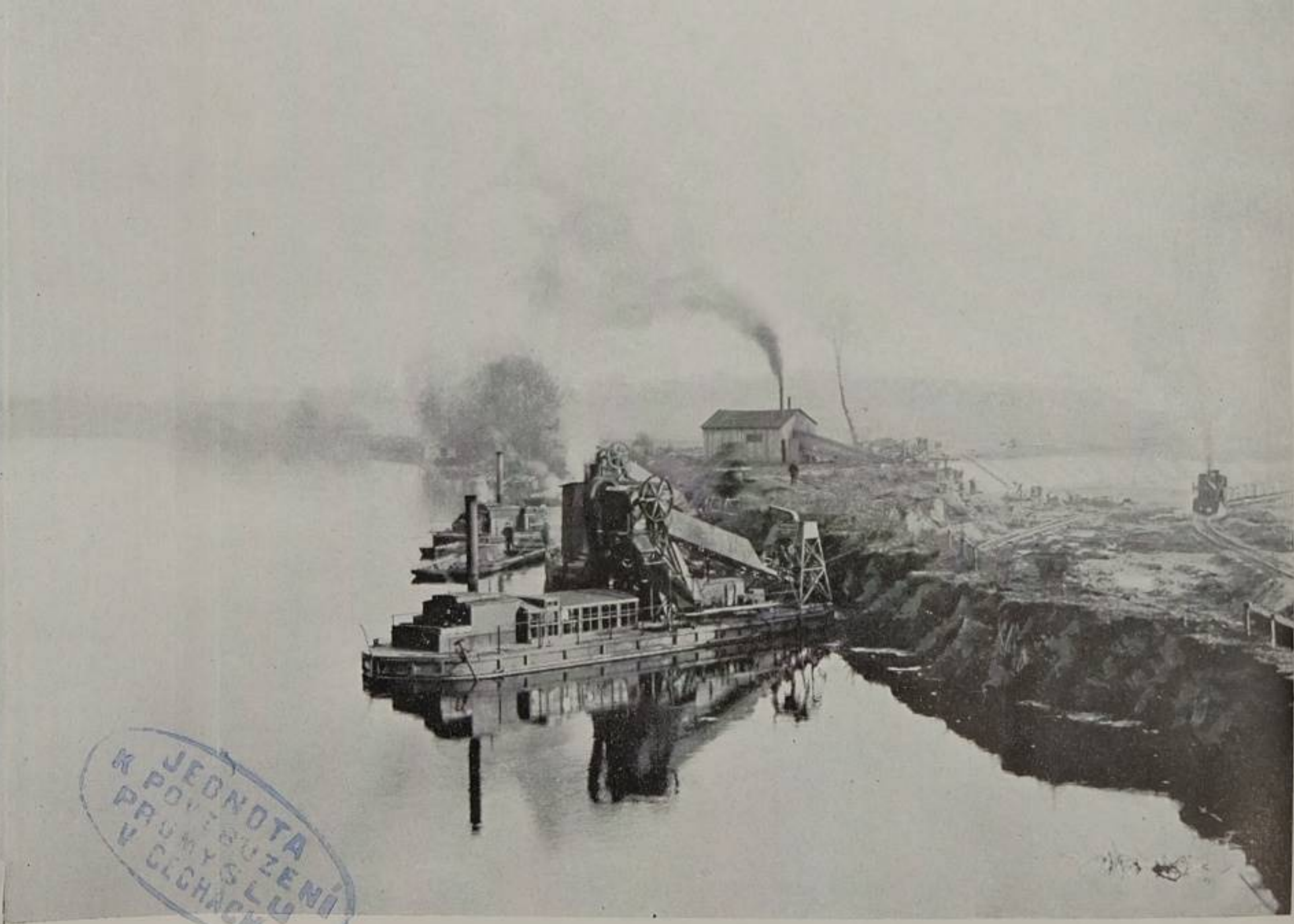
Obr. 12. Úprava u Obříství 1. prosince 1908. Pohled na úpravu pravého břehu, starého řečiště labského pod průkopem, a na stroje, hrázku mezi průkopem a řečištěm prorážející.
