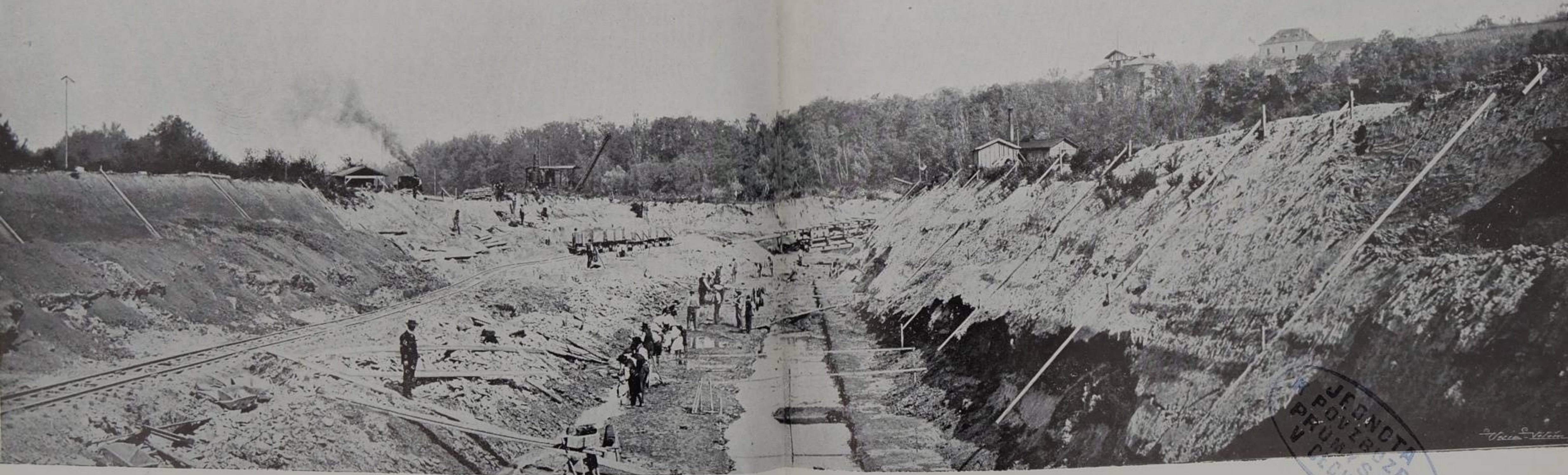
Obr. 16. Úprava u Mělníka 9. září 1908. Výkop v plavidle. Pohled s horního shlaví směrem po vodě.
