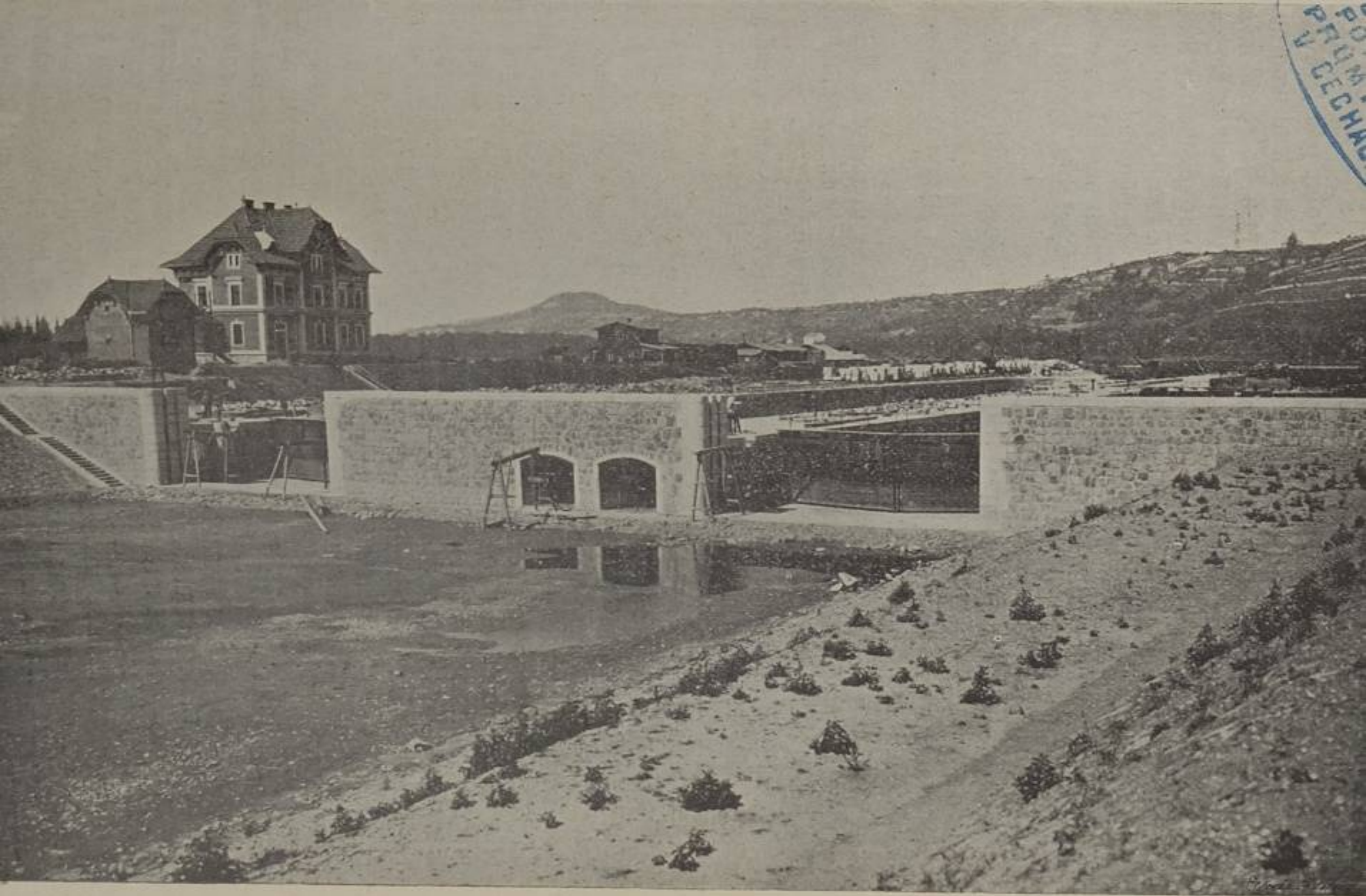
Obr. 4. Pohled na horní ohlavi plavidel ve Štětí. (Stav prací dne 17. července 1908.)
