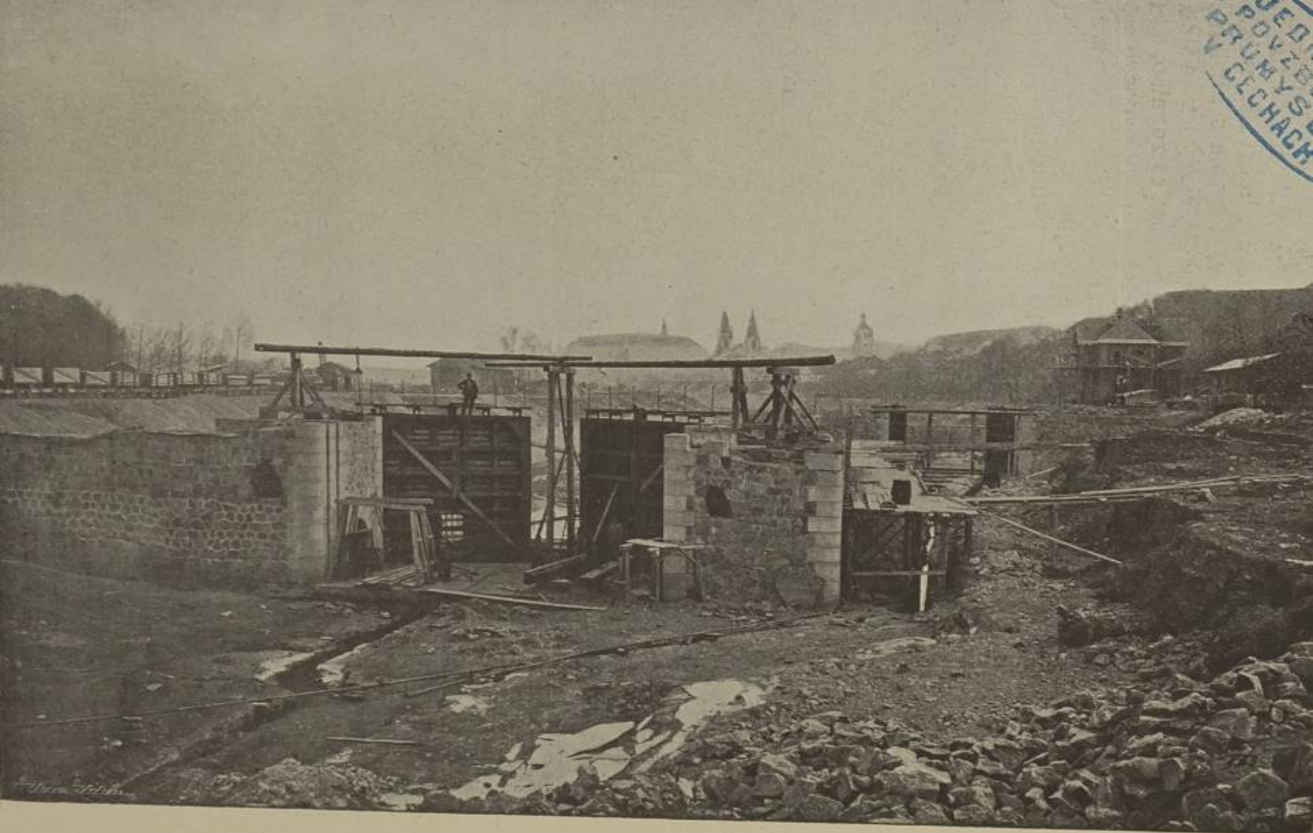
Obr. 7. Stavba plavidel u Roudnice na konci stavební sezony roku 1908.
