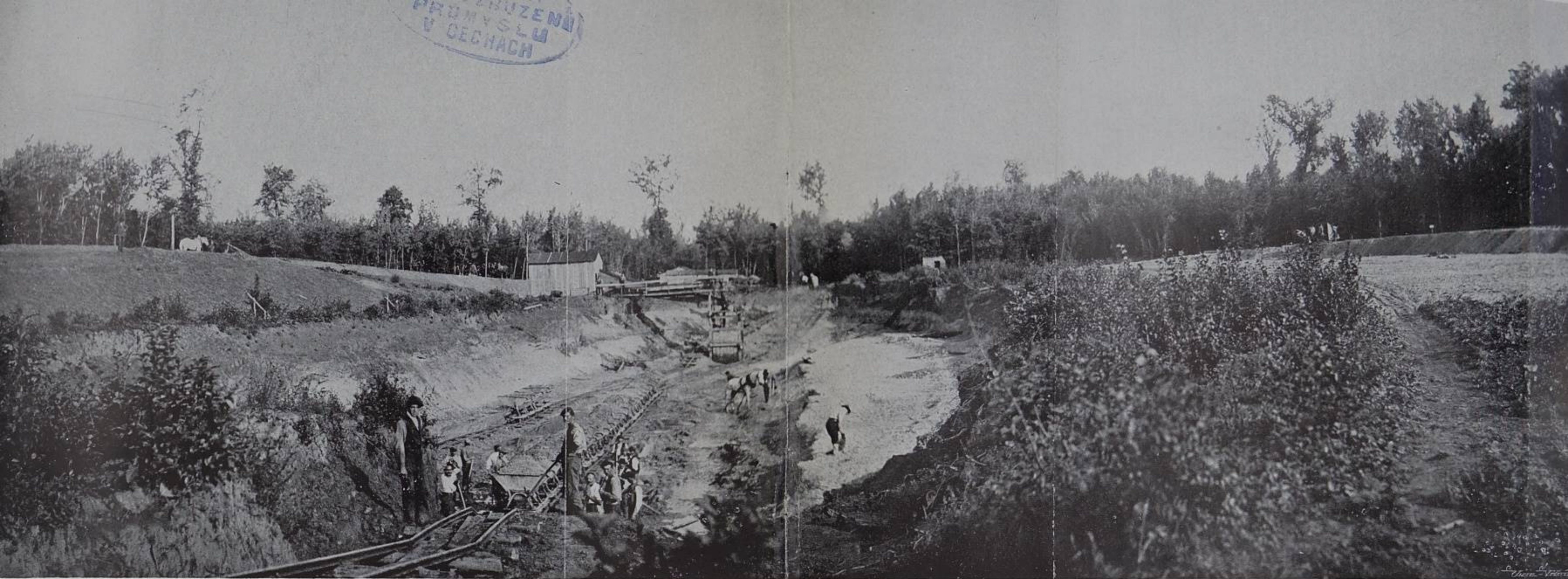
Obr. 13. Úprava u Obříství 10. září 1908. Výkop v komoře směrem po vodě.
