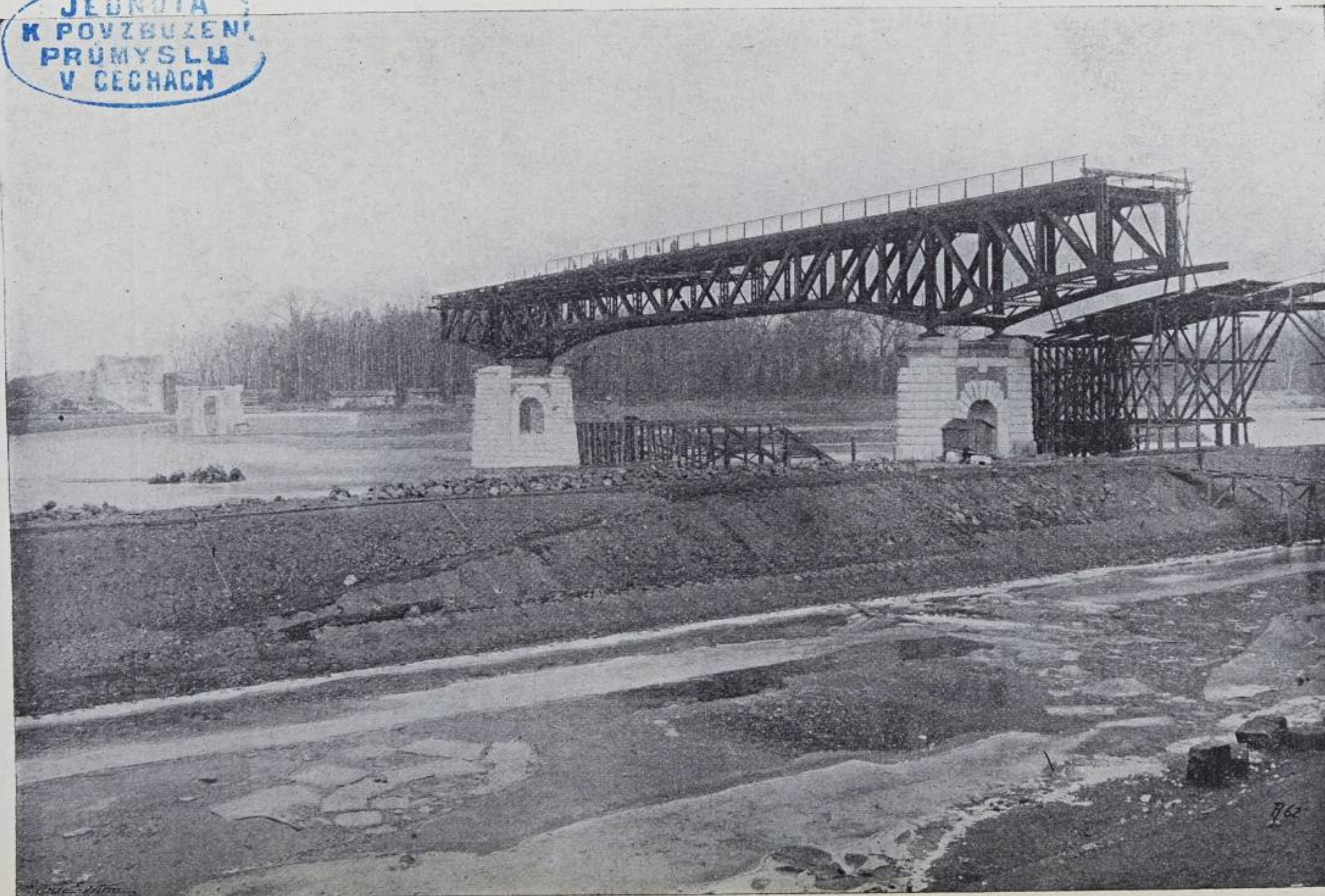
Obr. 6. Pohled na zmontované pole mostu přes lodní propust jezu v Roudnici.
