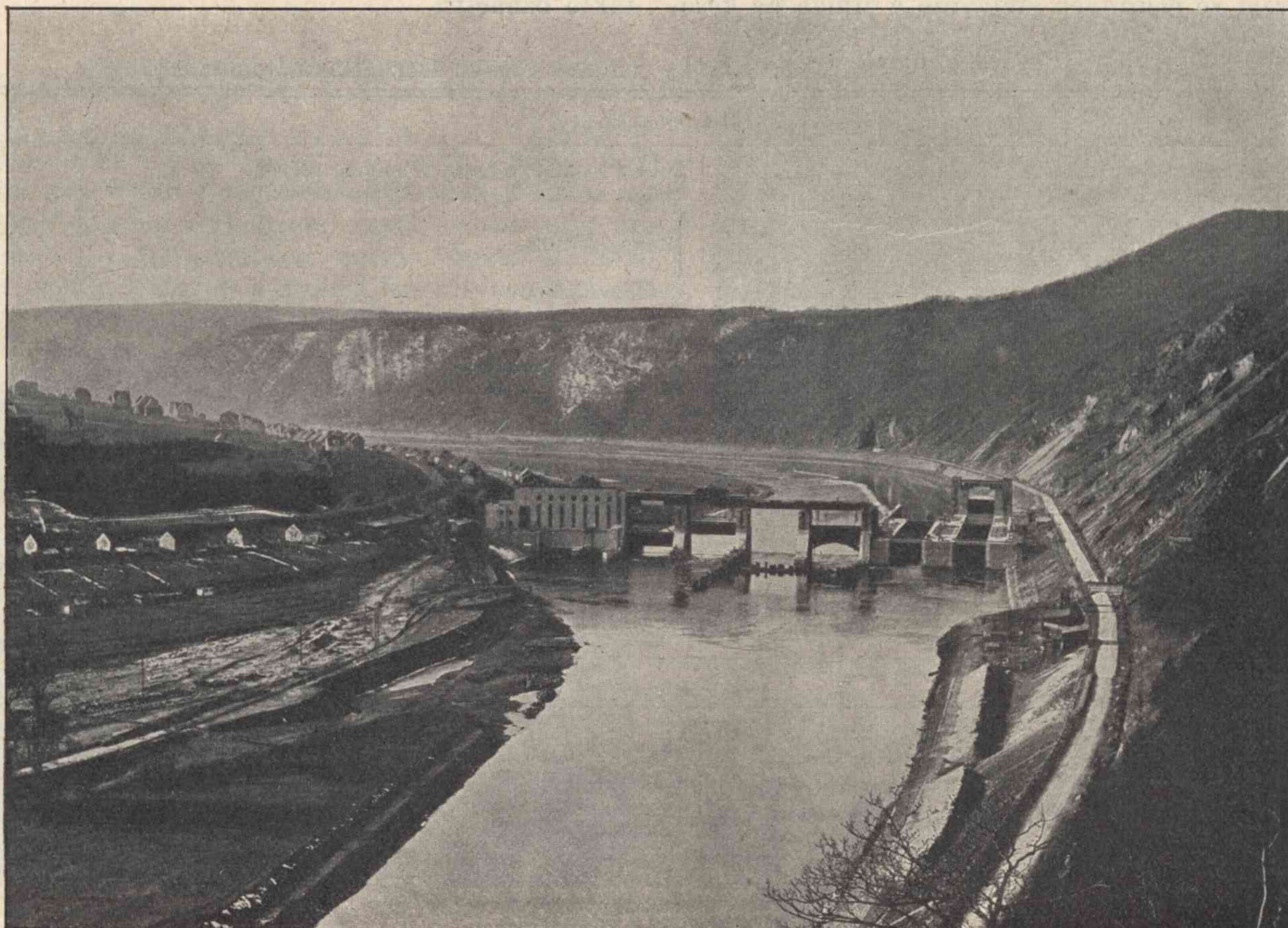
Obr. 35. Hotové vodní dílo před vzdouváním vody. Stav v létě 1935.
