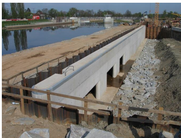
Obr. 2.3 Realizace dělicí zdi horní rejdy (duben 2010).
